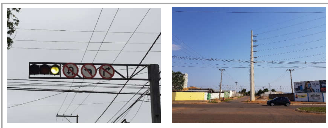
Figura 62: Excesso de informação de sinalização vertical
