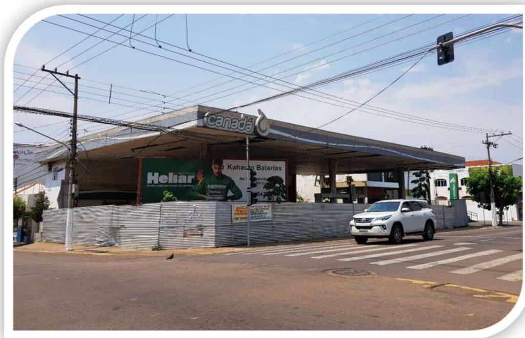
Figura 55 - Vazio Urbano Predial: Rua Fernando Correia da Costa com Avenida Amazonas. Fonte: Urbaniza Engenharia Consultiva.
