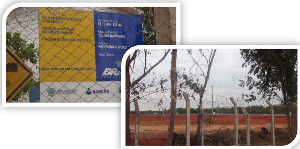
Figura 94: Ampliação da ETE - SANEAR Fonte: Urbaniza Engenharia Consultiva, outubro / 2017.
