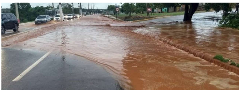
Figura 88: Alagamento Av. dos Estudantes, 9/11/2017 por falta de drenagem.
