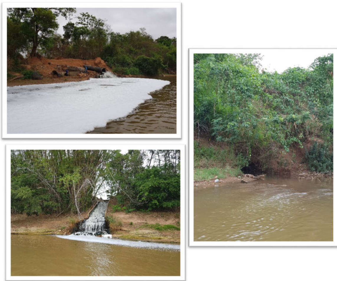
Figura 96: Lançamento de esgoto no Rio Vermelho Fonte: Urbaniza Engenharia Consultiva, outubro / 2017.
