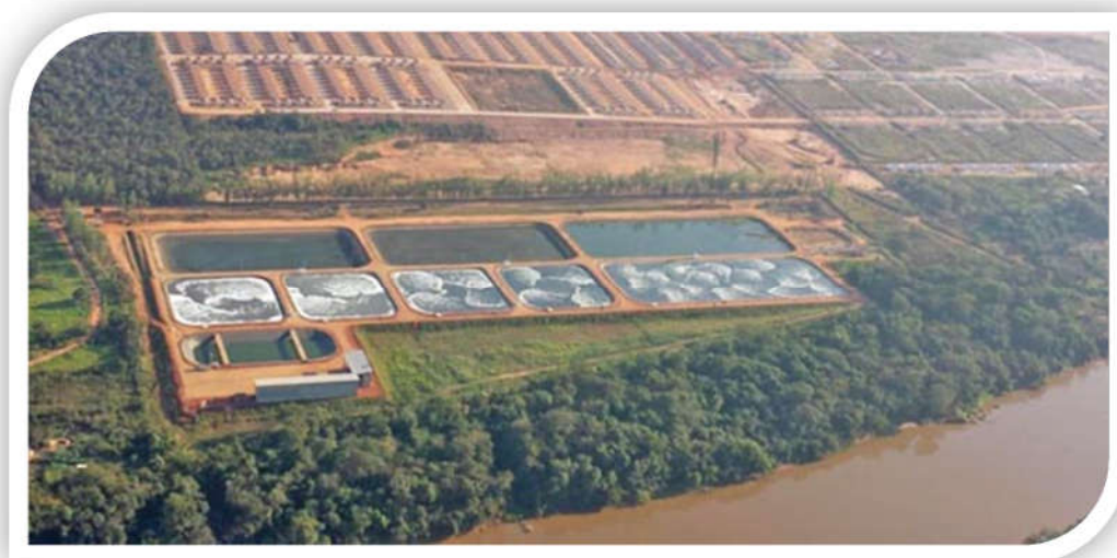
Figura 95: Ampliação da ETE - SANEAR Fonte: www.tribunamt.com.br ; julho/2017
