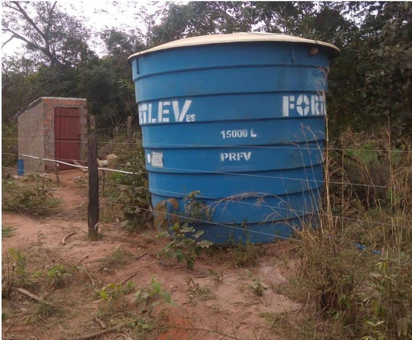
Figura 24 - Poço e caixa de 15.000 L para armazenamento da água que abastece a comunidade.
