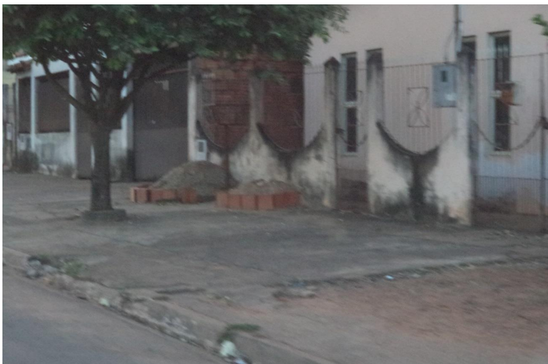
Figura 38 – Lote com edificação, e a falta de calçamento para passagem do pedestres.
