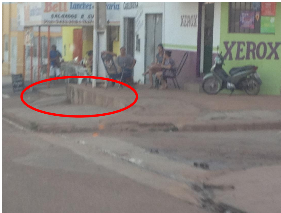
Figura 99 101 – Presença de declínio elevado do calçamento para a faixa de passeio na calçada.
