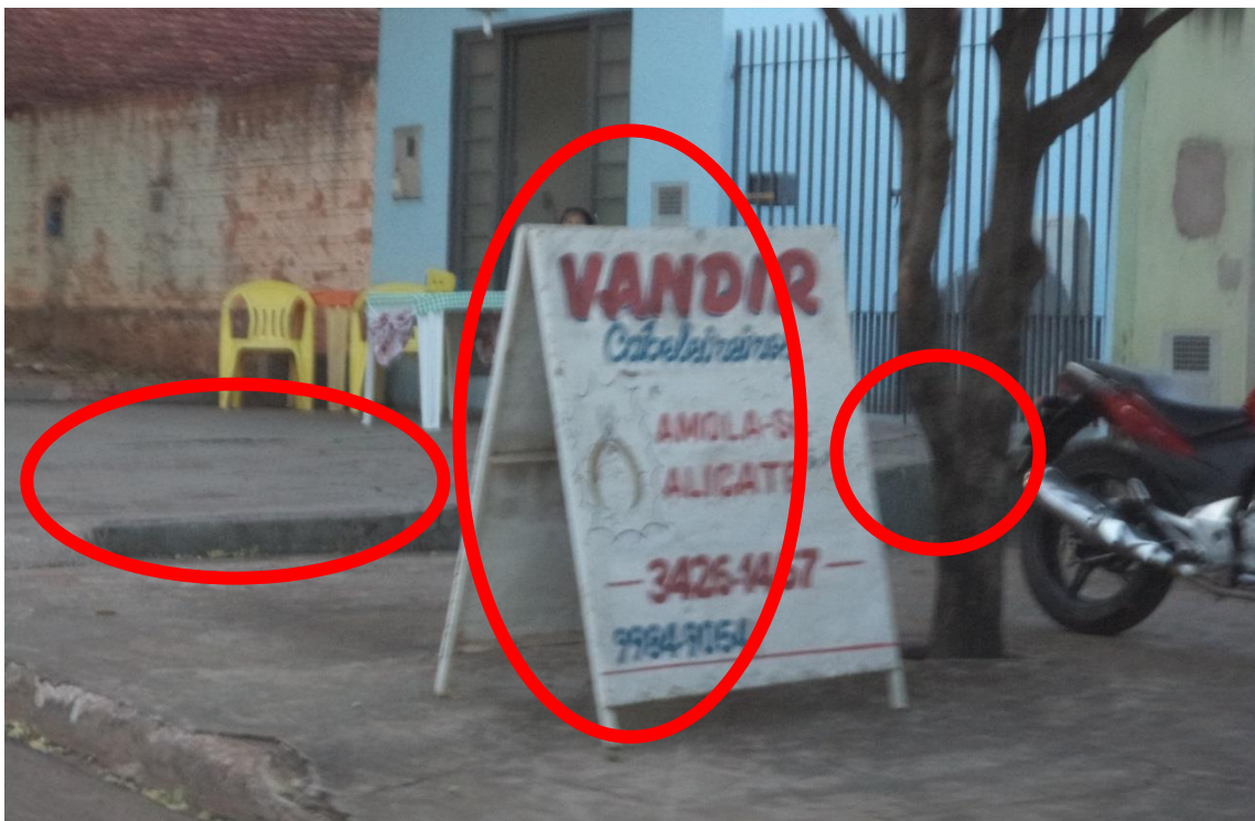
Figura 34 – Presença de elevação na calçada e propaganda de cabeleireiros com placa dentro da faixa de passeio.
