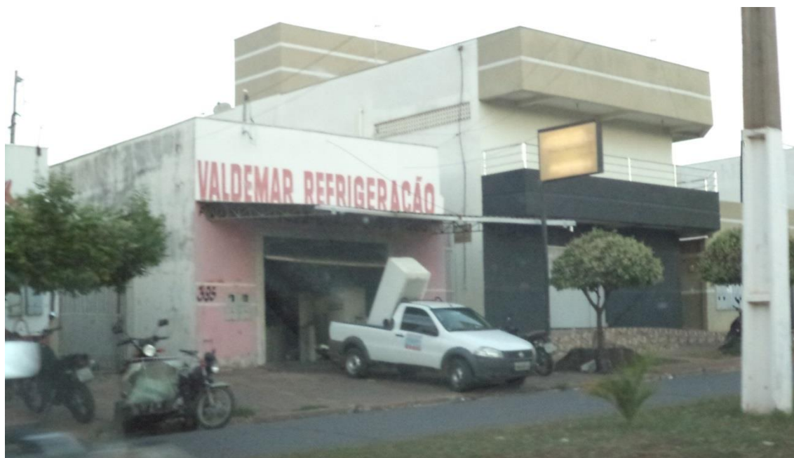
Figura 56 – Refrigeração utilizando calçada para carregar e descarregar mercadorias.
