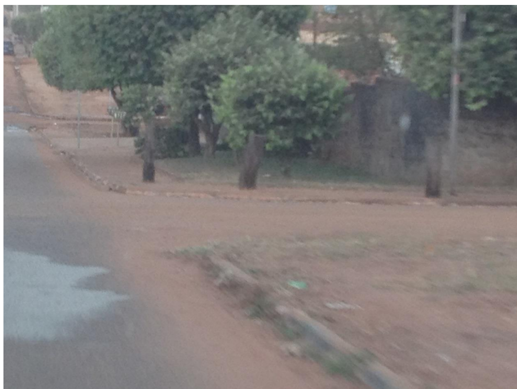
Figura 112 – Falta de calçamento nas duas quadras, e em partes presença de calçada parcialmente.
