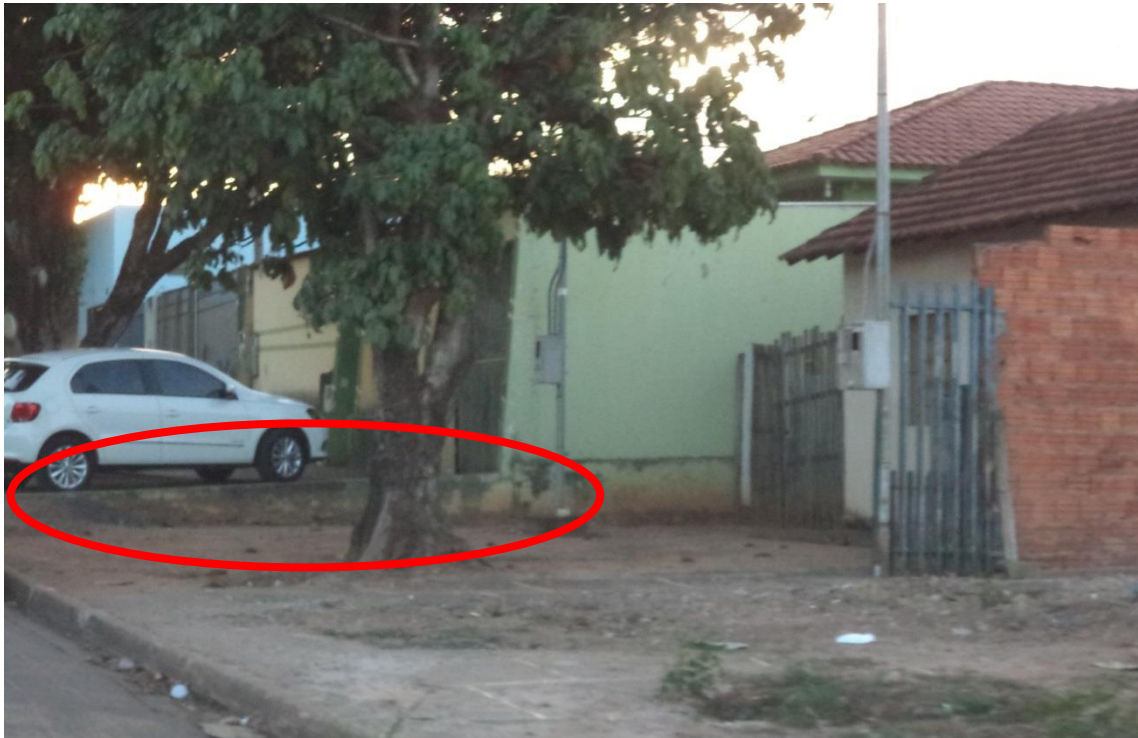
Figura 34 – Presença de elevação na calçada e propaganda de cabeleireiros com placa dentro da faixa de passeio.
