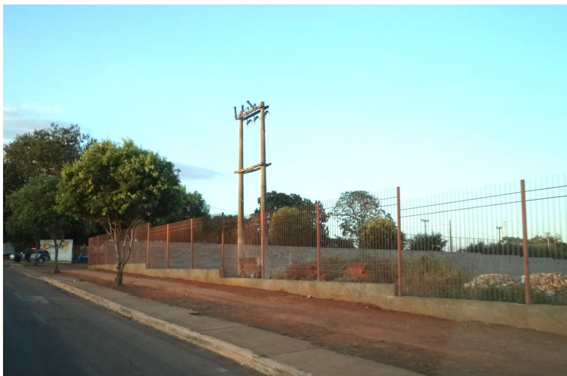
Figura 16 – Área com calçada em parcial, outra parte ainda em solo batido.
