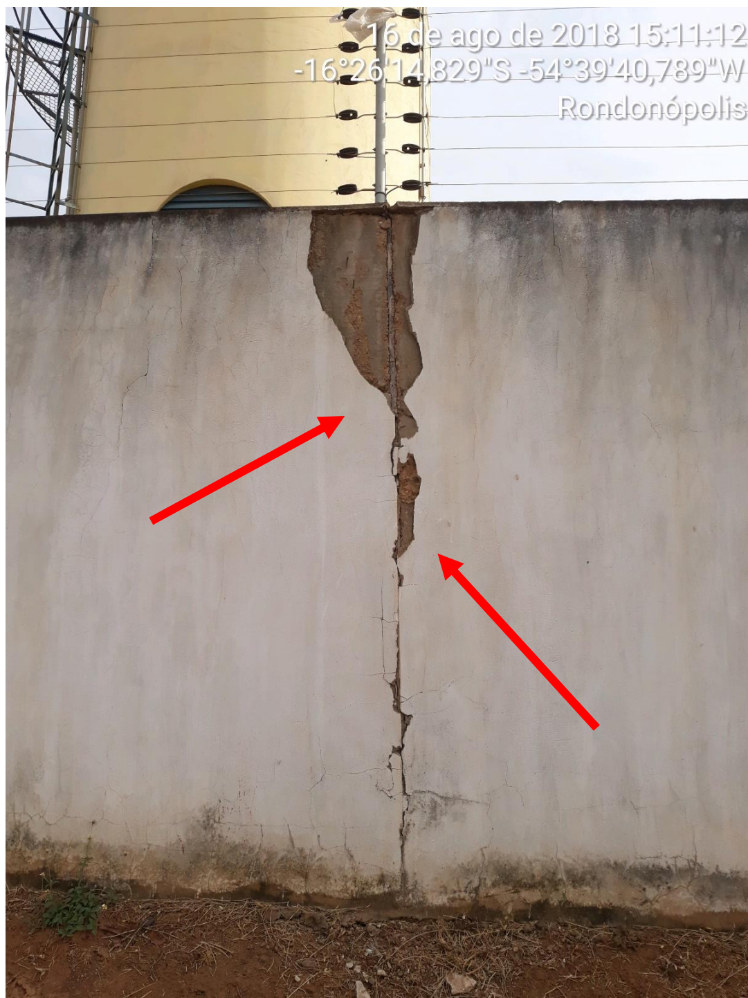
Figura 6 - Muro comprometido
