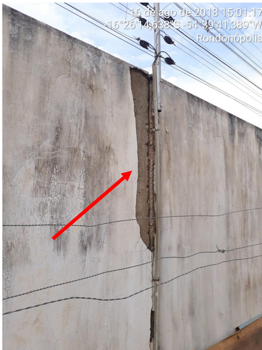
Figura 2 – Muro comprometido
