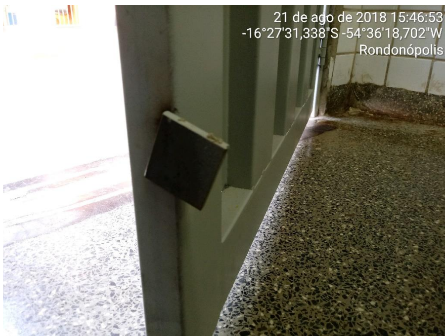
Mau acabamento na solda das portas – Bloco 2
