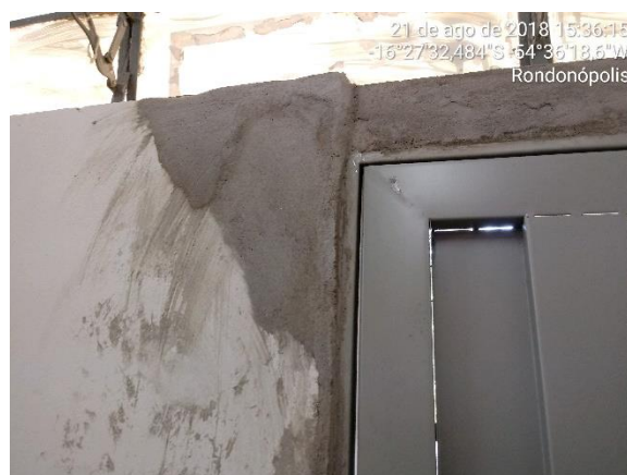
Falta de acabamento nos requadros das portas das salas do segundo bloco
