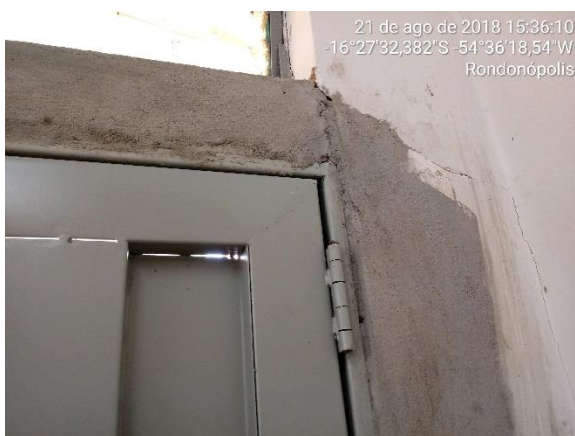
Falta de acabamento nos requadros das portas das salas do segundo bloco
