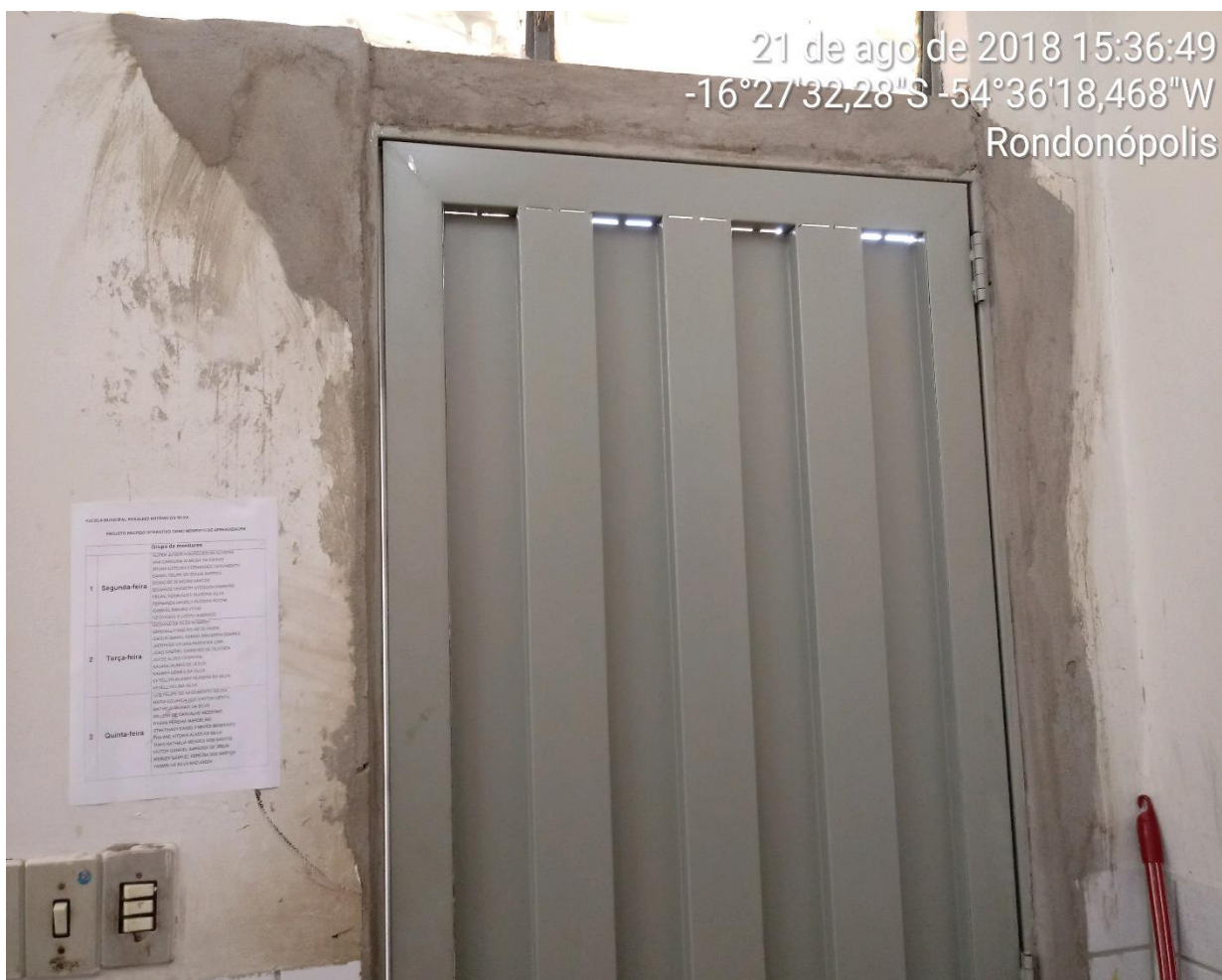
Falta de acabamento nos requadros das portas das salas do segundo bloco
