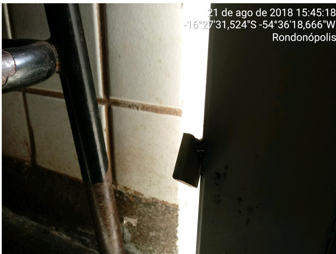
Mau acabamento na solda das portas – Bloco 2
