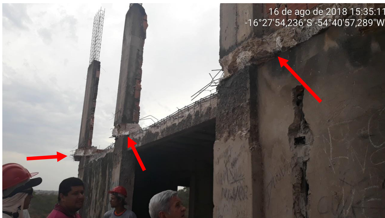
Figura 5 - Pilar sem ancoragem na face inferior, executado sobre o EPS da laje.
