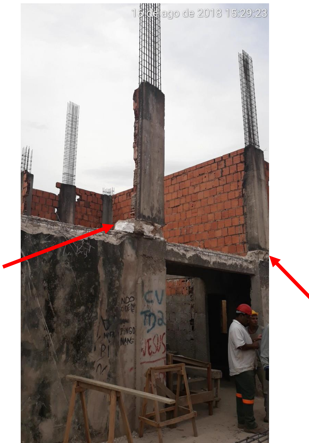
Figura 3 - Pilar sem ancoragem na face inferior, executado sobre o EPS da laje.
