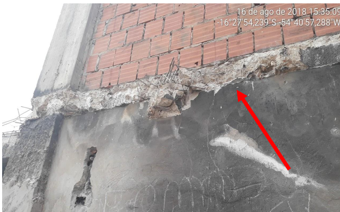
Figura 5 - Pilar sem ancoragem na face inferior, executado sobre o EPS da laje.
