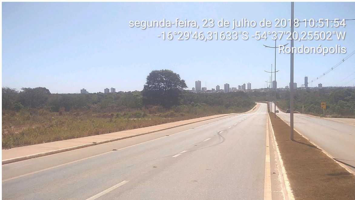
Foto 4 – Situação da obra “ Construção de Alamedado Av. Beira Rio (Contrato 144/2018)
