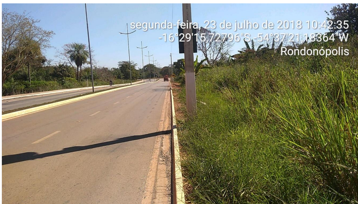
Foto 1 – Situação da obra “ Construção de Alambrado Av. Beira Rio (Contrato 144/2018)
