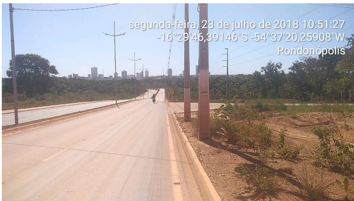
Foto 3 – Situação da obra “ Construção de Alamedado Av. Beira Rio (Contrato 144/2018)
