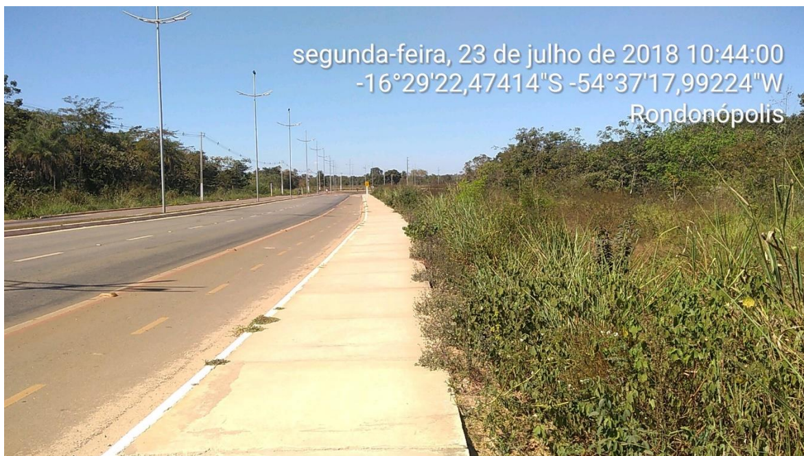
Foto 2 – Situação da obra “ Construção de Alambrado Av. Beira Rio (Contrato 144/2018)
