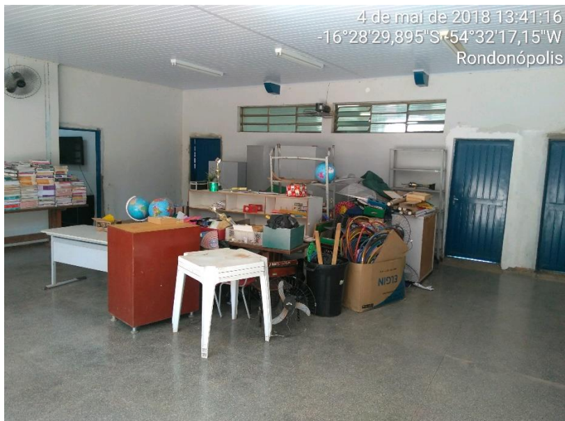
Foto 02 – Pátio servindo de depósito causando transtorno (Escola Vila Paulista – Contrato 349/2017)
