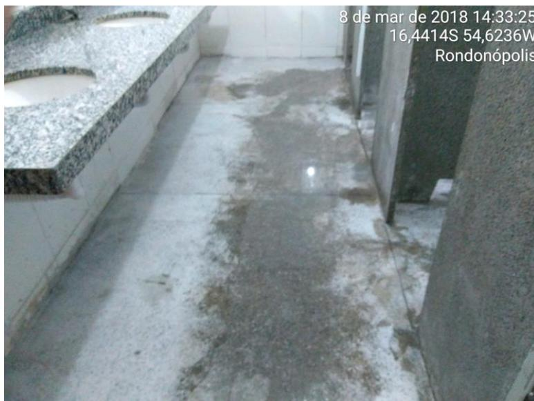
Foto 02 – Detalhe do piso em granilite com poças d'água (executada pela Contratada)
