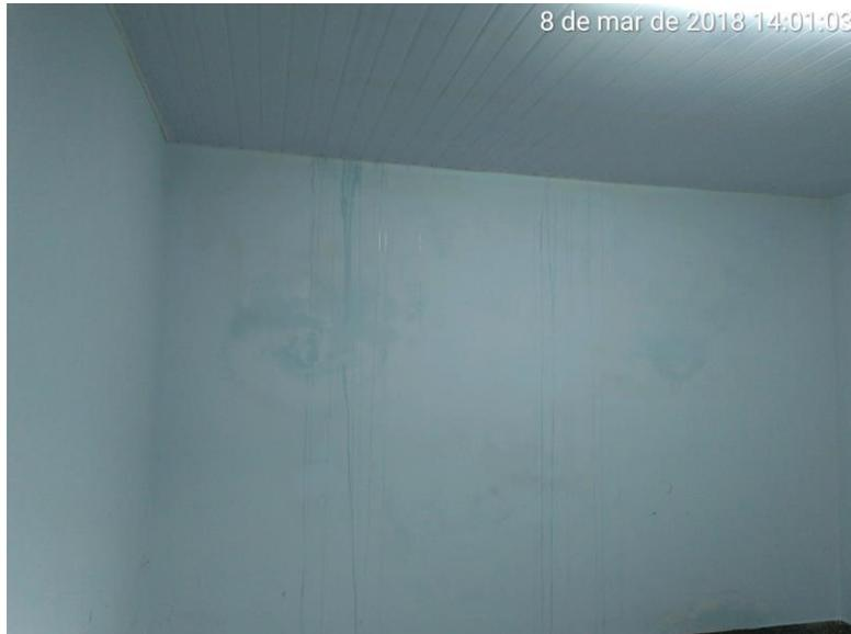
Foto 01 – Detalhe das paredes com infiltrações (executada pela Contratada)
