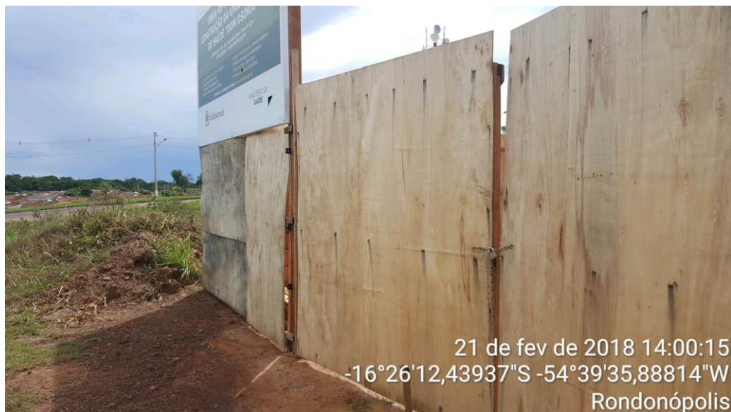
Foto 01 – Obra fechada/trancada (UBS Dom Osório – Contrato 324/2017)
