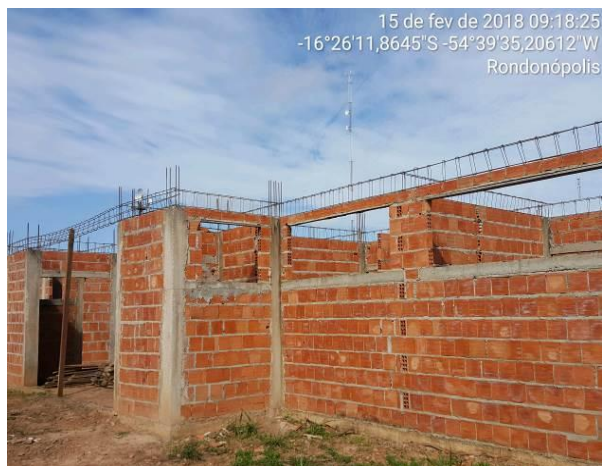
Figura 05 – Edificação sem a laje e viga
