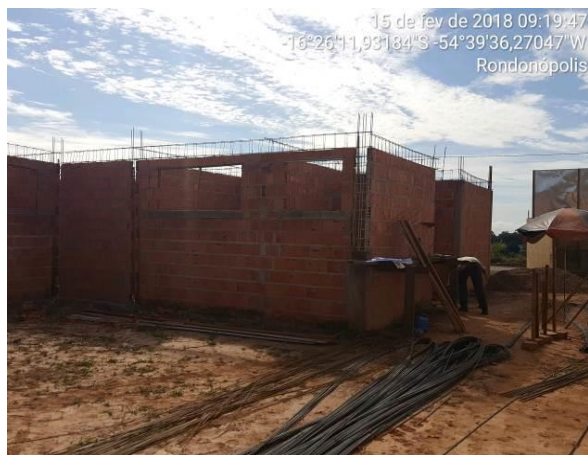
Figura 06 – Edificação sem a laje, viga e pilar
