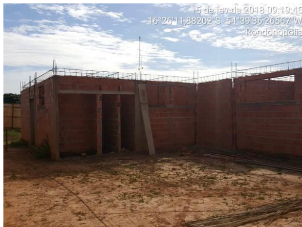
Figura 03 – Parte externa da obra
