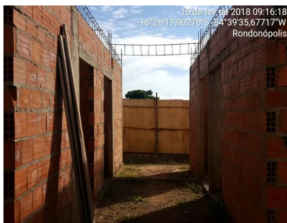
Figura 08 – Alvenaria incompleta
