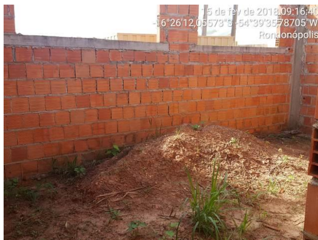
Figura 02 – Parte interna da obra
