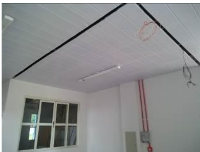
Figura 25 – Abertura no forro para fixação de divisórias de gesso
