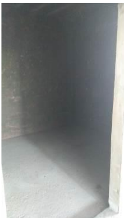
Figura 6 – Provável câmara frigorífica 6
