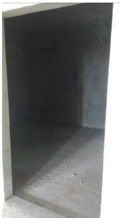
Figura 7 – Provável câmara frigorífica 7
