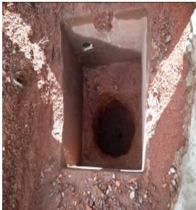
Figura 36 – Tubulação de água pluvial em caixa cega
