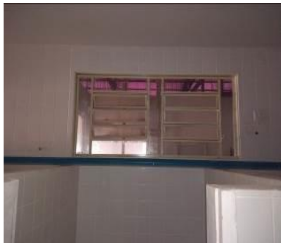
Figura 24 – Janela do banheiro feminino para o jardim de inverno
