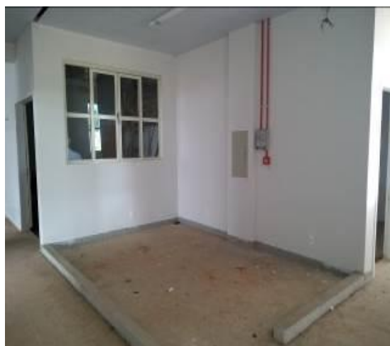
Figura 26 – Ambiente aonde serão fixadas divisórias de gesso
