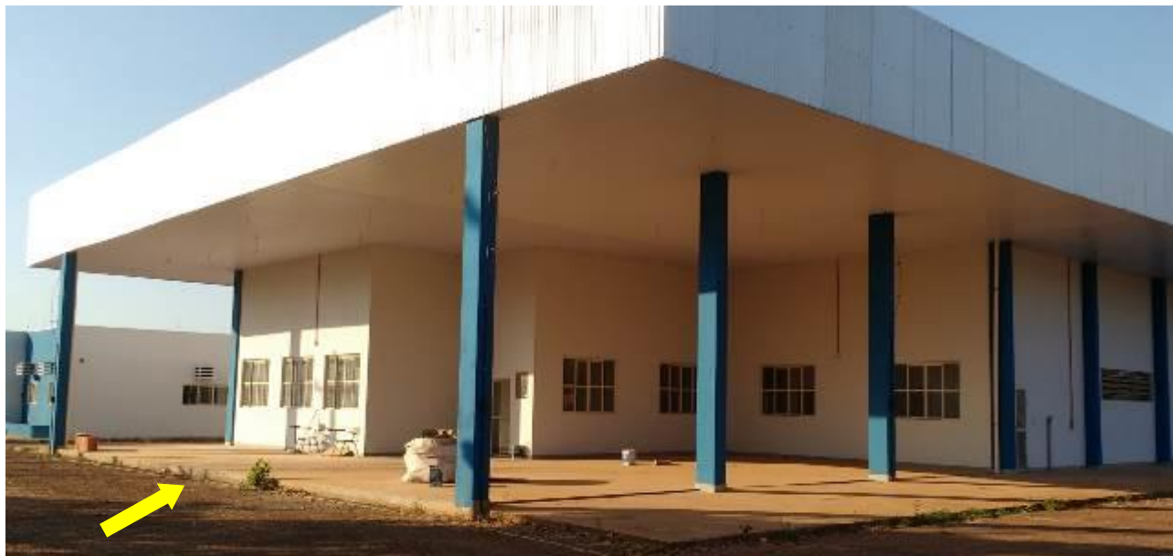
Figura 45 – Fachada do Centro de Beneficiamento de Produtos de Origem Animal
