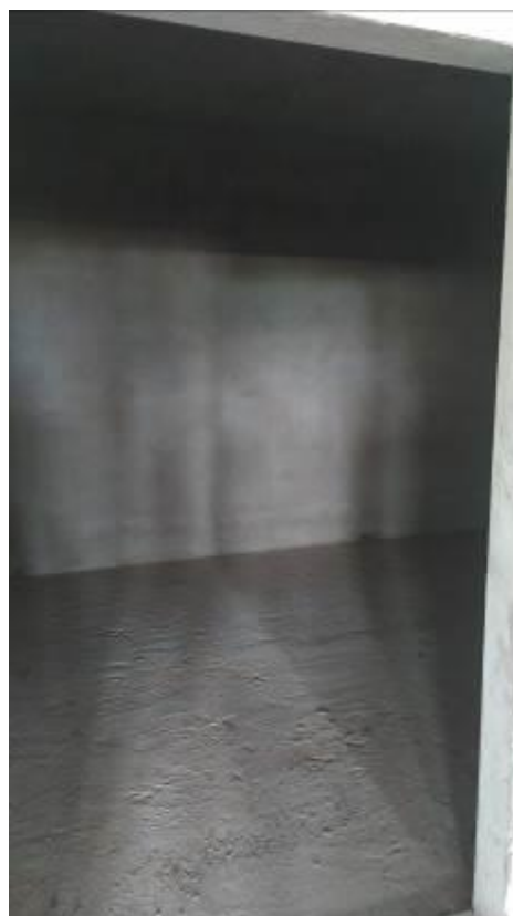
Figura 3 – Provável câmara frigorífica 2
