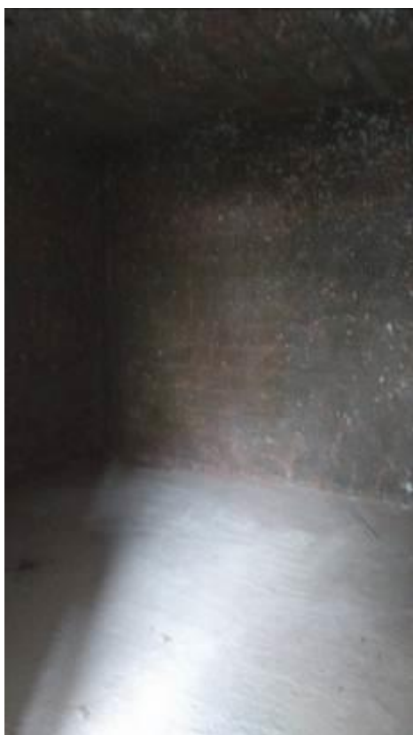
Figura 2 – Provável câmara frigorífica 1
