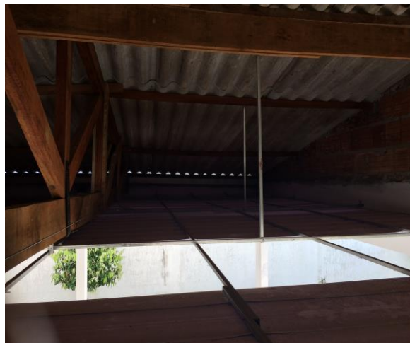
Foto dos perfis de sustentação, de amarração e pendurais
