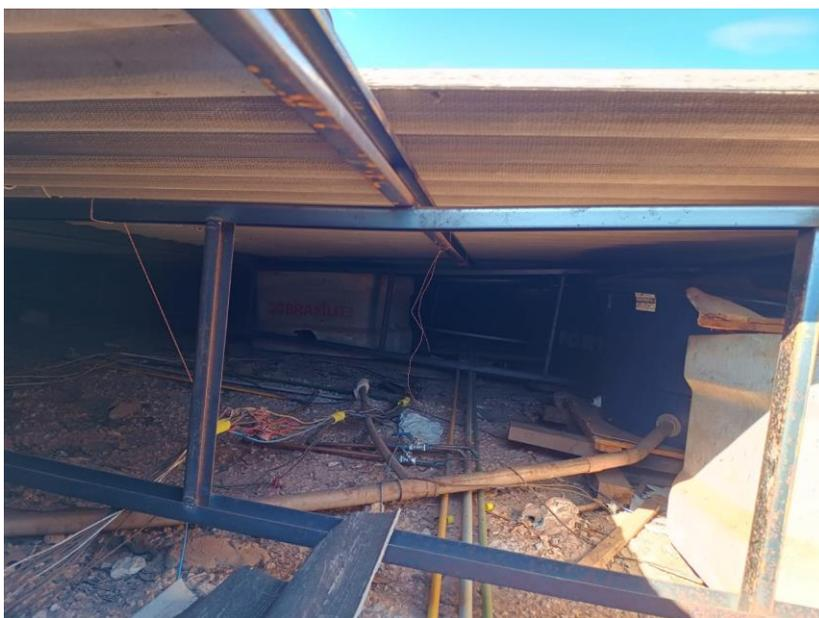
Terça instalada fora do nó da treliça provocando deformação no banzo superior
