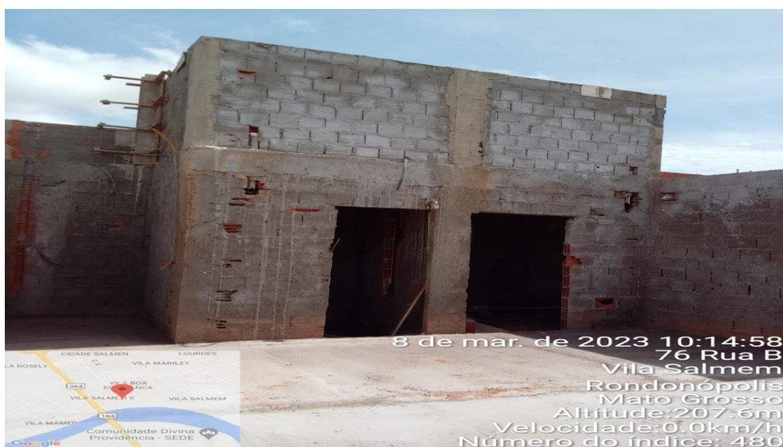
Foto 04 – áreas internas sem atividades em varias frentes de serviços.
