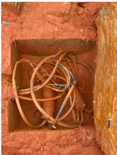
*Figura 1: Falta de brita no fundo e excesso de lama nas caixinhas de elétrica.*
