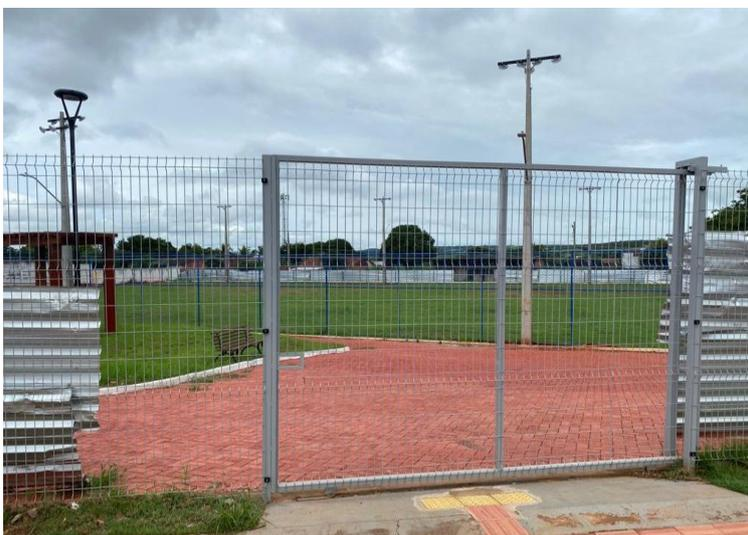
*Figura 5: Falta de fixação do tapume de fechamento.*
