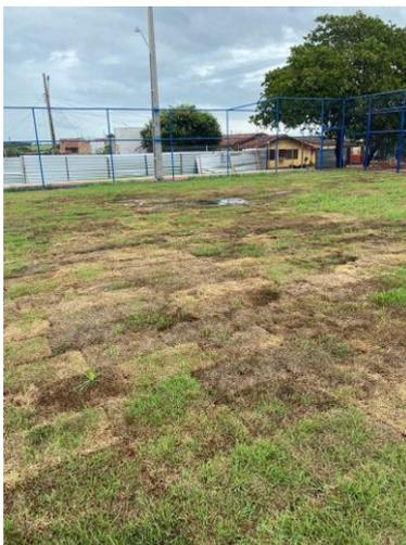
*Figura 3: Grama queimada, falta de nivelamento e empoçamento.*
