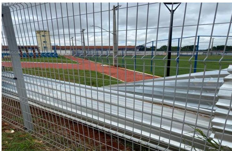
*Figura 4: Falta de fixação do tapume de fechamento.*
