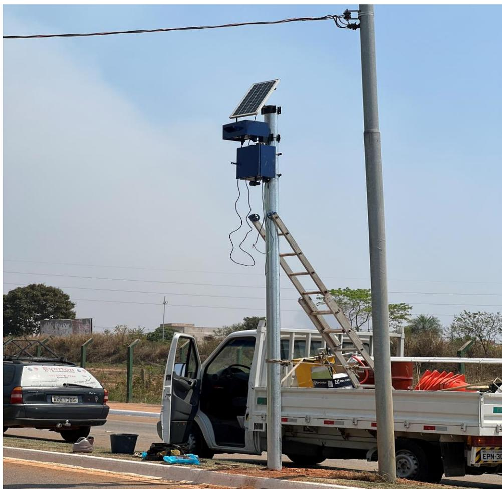
**7.3** O detector de altura excedente reduz os riscos de acidentes ele detecta e informa sobre os veículos que apresentam riscos de impacto contra as estruturas de pontes, viadutos, passarelas, túneis, fiação etc.
