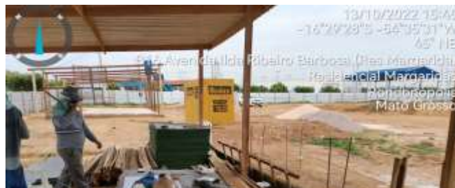
Imagem 04: Presença de 2 funcionários na obra.
