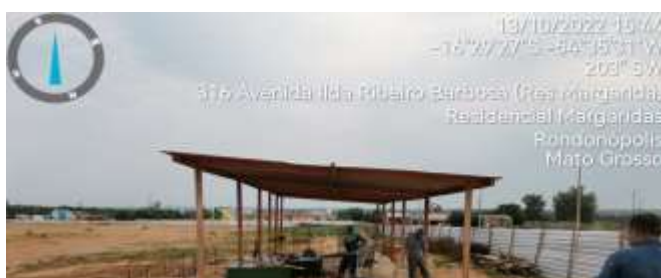
Imagem 01: Presença de 2 funcionários na obra.
