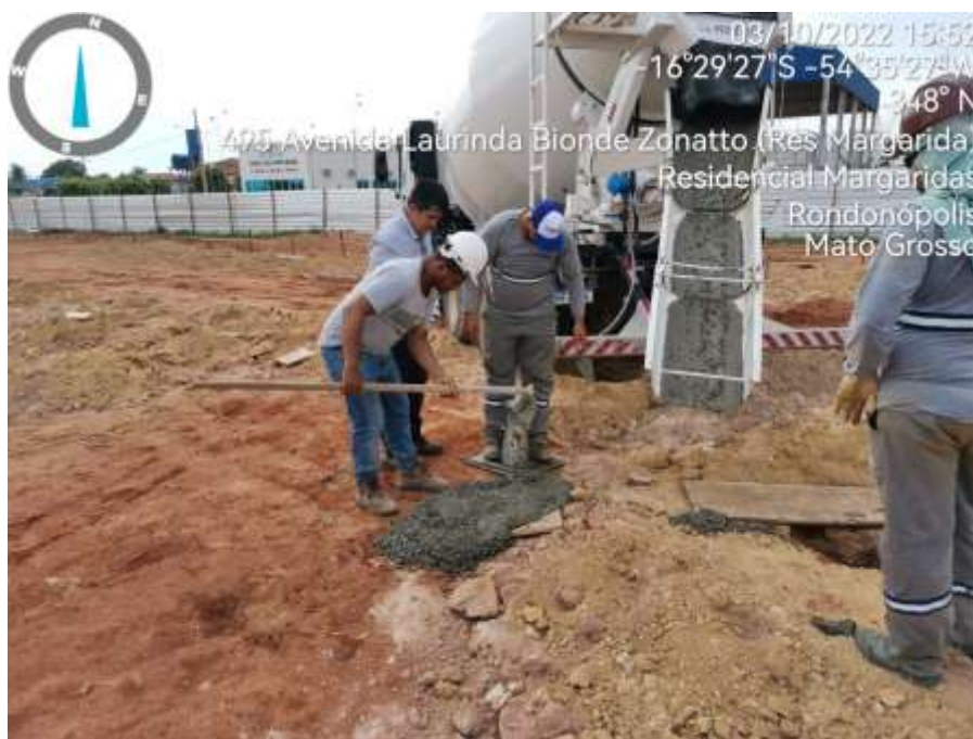
Imagem 07: Contratada na 3ª tentativa de realização do Slump Test.
