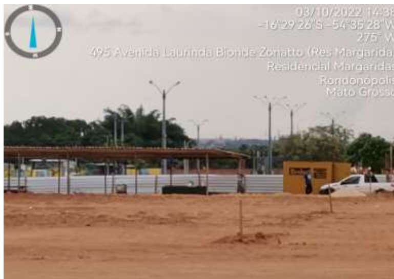
Imagem 01: Presença de 2 funcionários na obra
