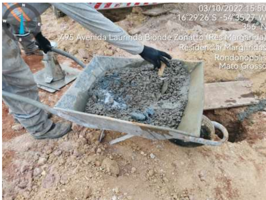
Imagem 03: Concreto retirado do caminhão com restos de sacos de cimento, cimento sem estar homogêneo.
