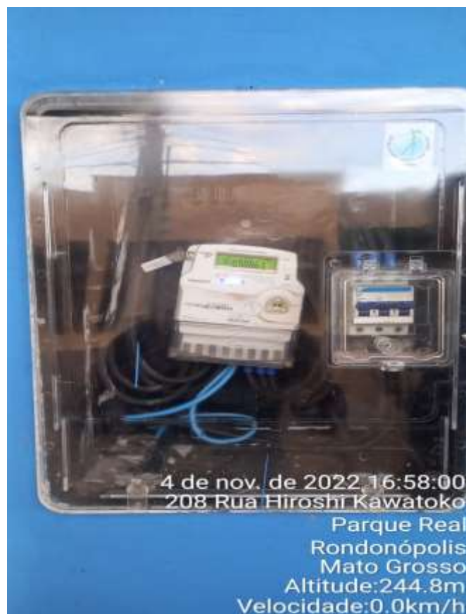
Figura 03: Tampa do quadro sem parafuso
