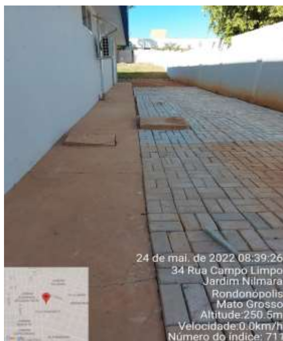
Foto 11 – falta colocar massa em volta de uma caixa de passagem, e falta rebaixar algumas tampas
