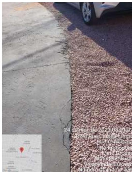
Foto 02 – Calçada nova de entrada da ambulancia .
