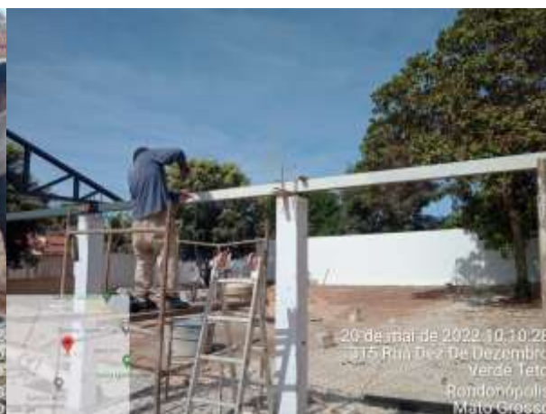
ESTRUTURAS DO TELHADO DA PASSARELA
