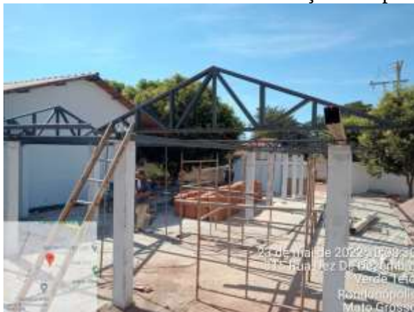
ESTRUTURAS DO TELHADO DA PASSARELA
