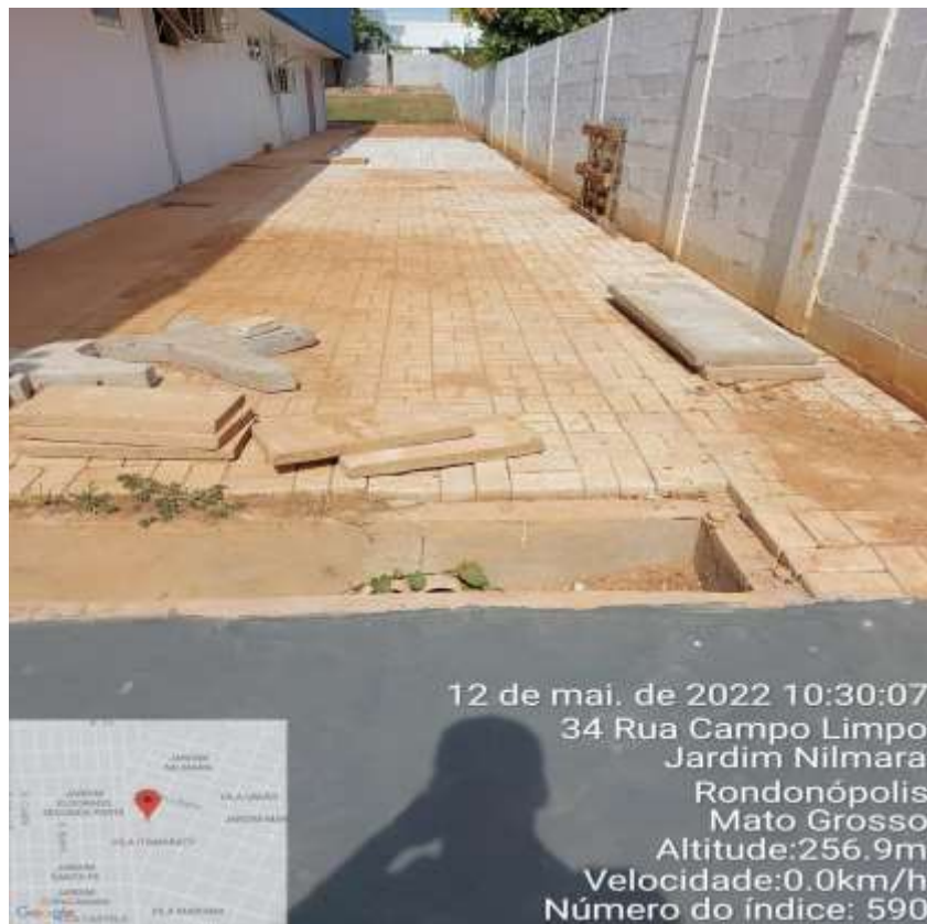
Foto 01 – Falta limpar a grelha e assentar as peças pré fabricadas.
