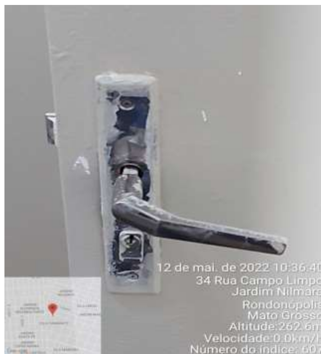
Foto 06 – fechadura respingada de tinta.
