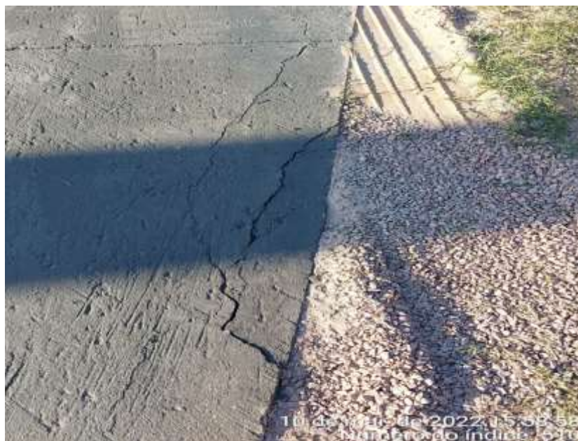
Foto 02 – Calçada nova de entrada da ambulancia .
