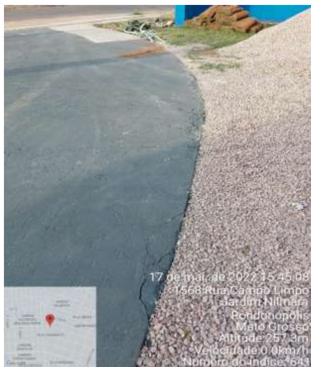
Foto 02 – Calçada nova de entrada da ambulancia .
