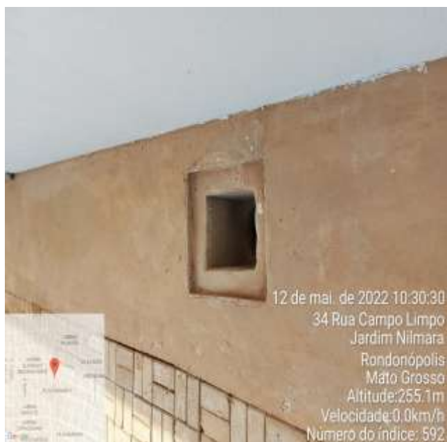
Foto 11 – falta uma tampa da caixa de passagem, e falta rebaixar algumas tampas
