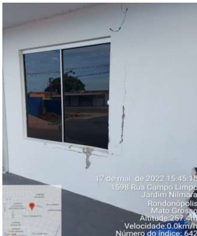
Foto 08 – Parede da janela da fachada onde a máquina quebrou na Hora de remover os entulhos.
