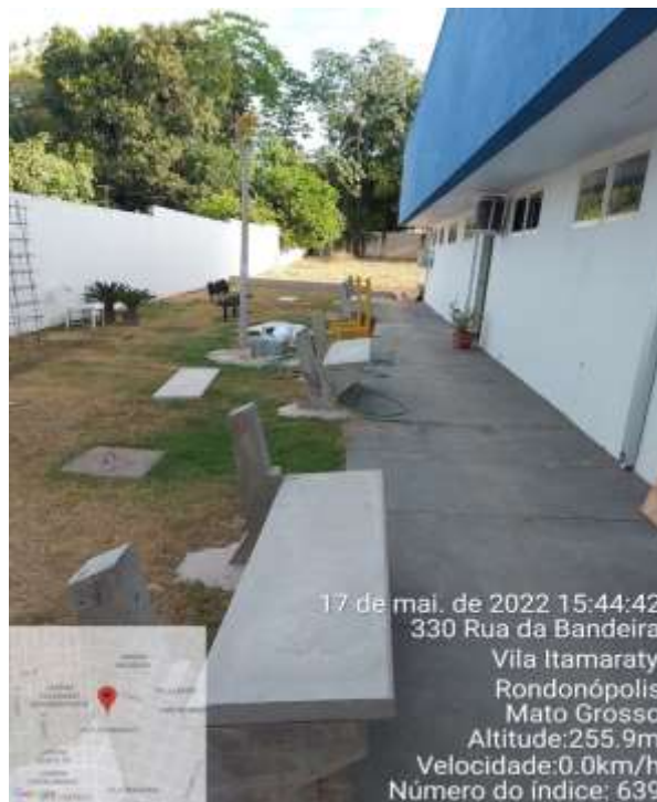
Foto 05 – falta parafusar a parte de cima dos bancos.
