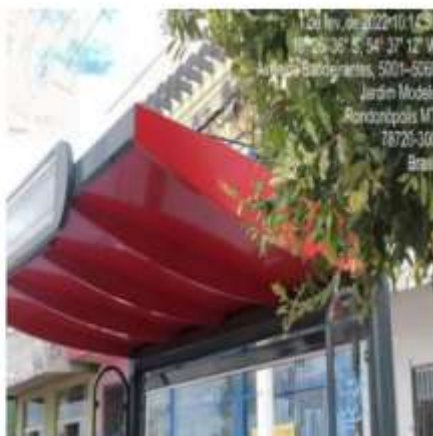
Fotos 52 e 53: abrigo localizado próximo ao posto Shell na Av. Bandeirantes está com oxidação em peças e amassados na chapa.
