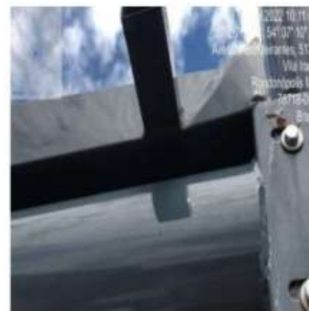
Fotos 52 e 53: abrigo localizado próximo ao posto Shell na Av. Bandeirantes está com oxidação em peças e amassados na chapa.
