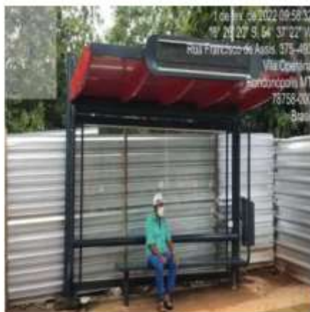
Fotos 40 e 41: abrigo localizado próximo à loja De Ville na Praça Bom Jesus, Vila Operária, está com falha de pintura nos tubos e oxidação.
