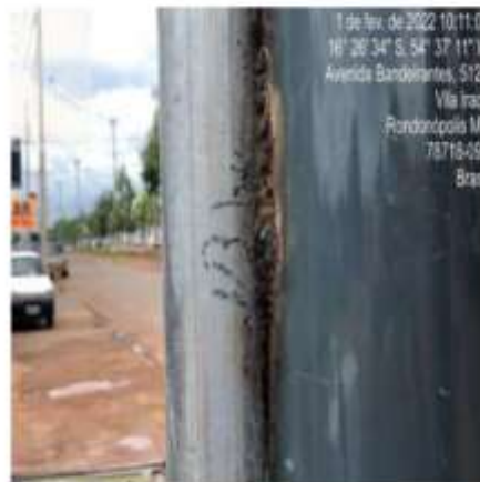
Fotos 50 e 51: abrigo localizado próximo à recuperadora de paracheque JM na Av. Bandeirantes está com a solda mal-acabada e com oxidações nos tubos.
