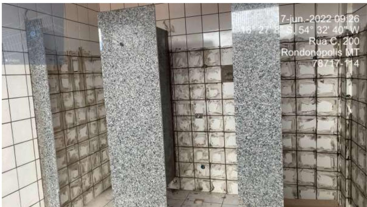
**FOTO 08 – rejunte inacabado, portas de alumínio das divisórias não instaladas.**
