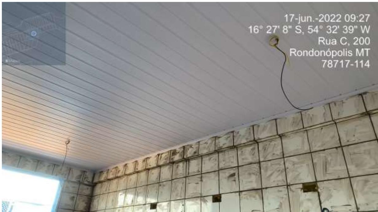
**FOTO 11 – rejunte inacabado, luminárias dos sanitários não instaladas.**
