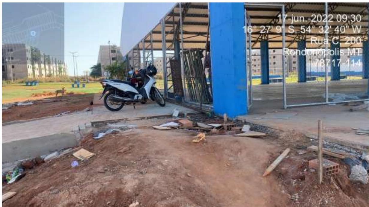
**FOTO 16 - calçada de concreto inacabada.**
