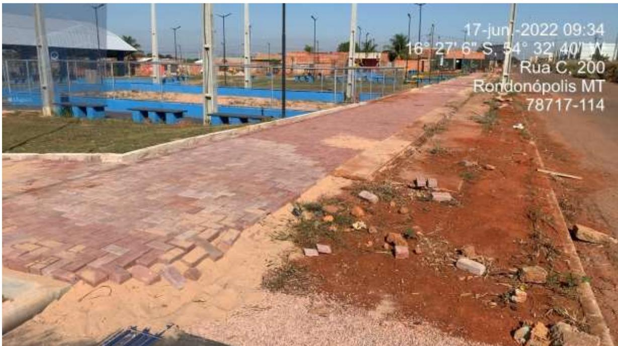
**FOTO 21 – Falta finalizar a calçada externa, falta instalar o piso tátil, o piso intertravado possui coloração diferente, uma parte mais escura e outra parte mais clara.**
