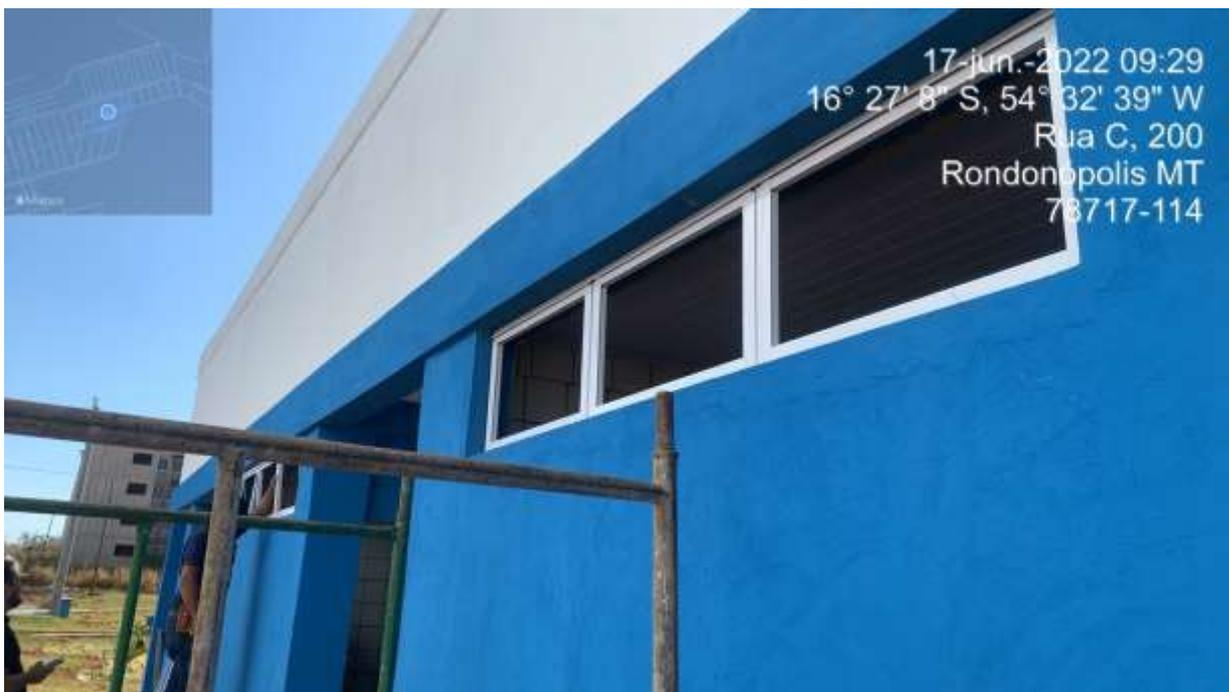
**FOTO 14 – instalações das janelas de alumínio (sem os vidros).**
