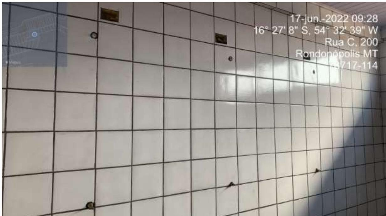
**FOTO 23 – Falta finalizar a instalação elétrica como passagem dos cabos elétricos das tomadas, falta a instalação dos chuveiros elétricos, falta a instalação dos acabamentos dos registros.**
