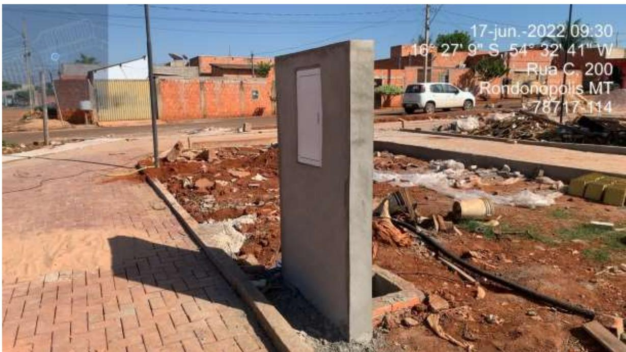
**FOTO 18 – mureta de alvenaria das instalações elétricas inacabadas (falta pintura), muito entulho na obra.**
