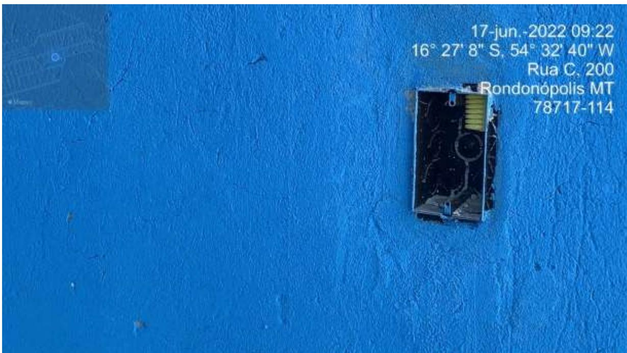
**FOTO 04 – Instalações elétricas não concluídas.**
