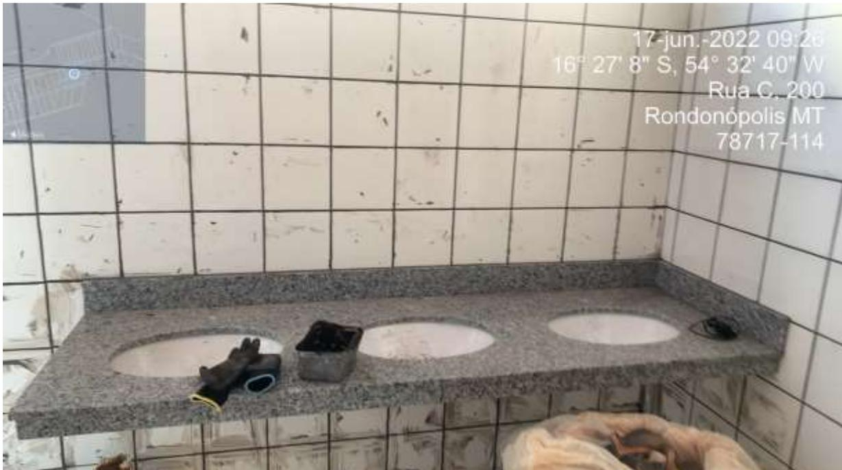
**FOTO 09 – torneiras das bancadas de granito não instaladas.**
