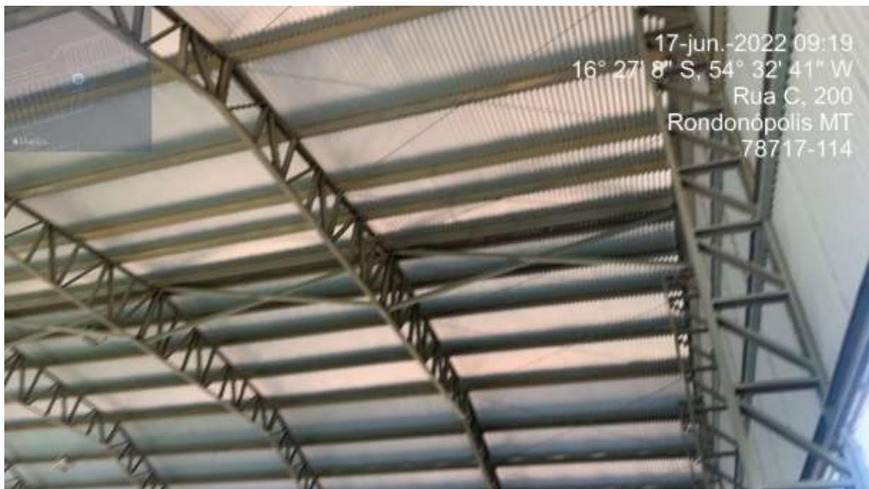
**FOTO 02 – Má distribuição das luminárias da quadra poliesportiva – em desacordo com o projeto, e falta a instalação de 01 unidade de luminária.**
