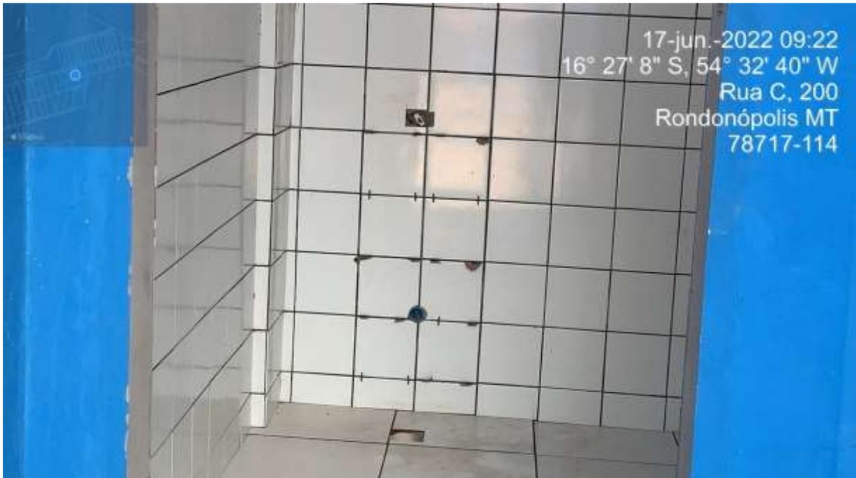
**FOTO 05 – falta de rejunte nas paredes, falta de acabamentos nas válvulas hidra, falta de instalação dos sanitários.**
