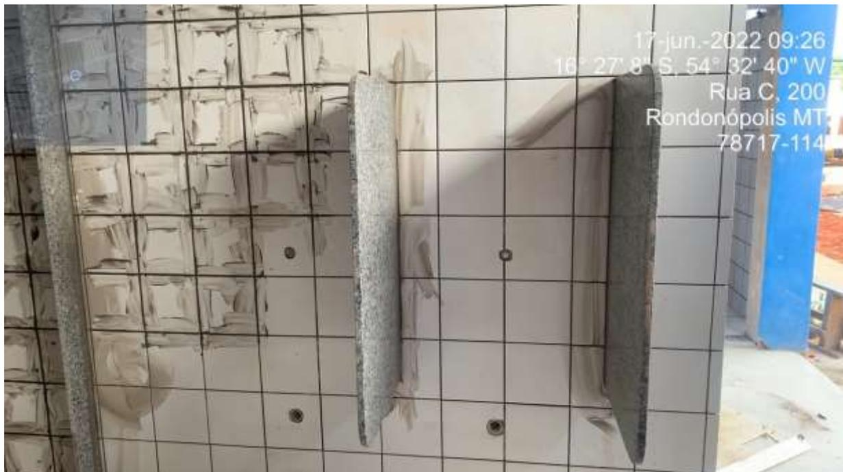
**FOTO 07 – Rejunte inacabado, mictórios não instalados.**
