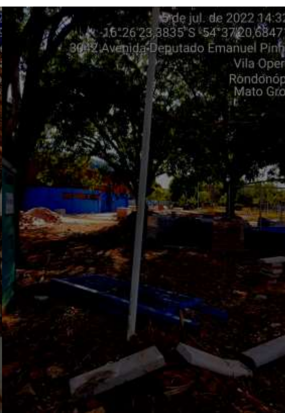
Poste inclinado com pintura danificada
