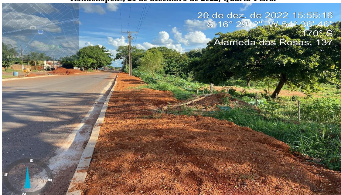
Foto 03 – Calçadas a executar.
