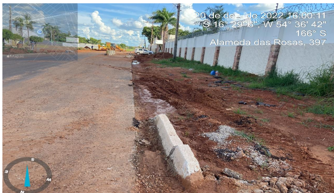
Foto 04 – Meio-fio, sarjeta, calçadas e plantio de grama a executar.
