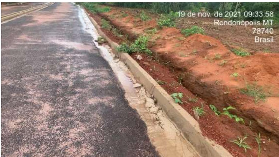
Foto 08 – Meio fio e sarjetas danificados por caminhão betoneira da contratada.
