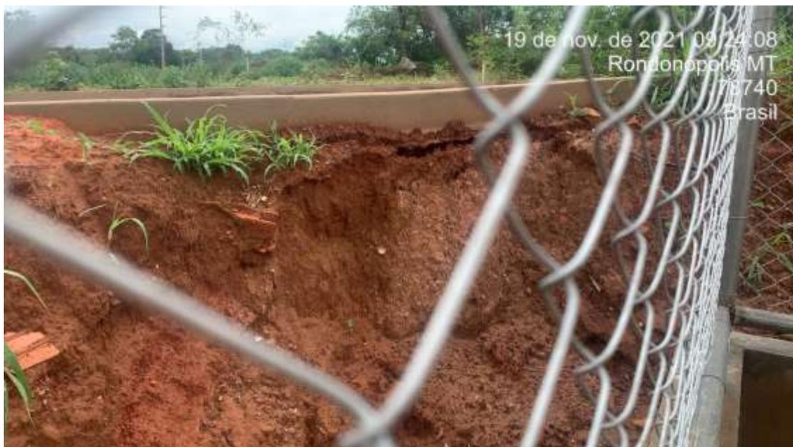
Foto 06 – Início de erosão, comprometendo a base e o meio fio.
