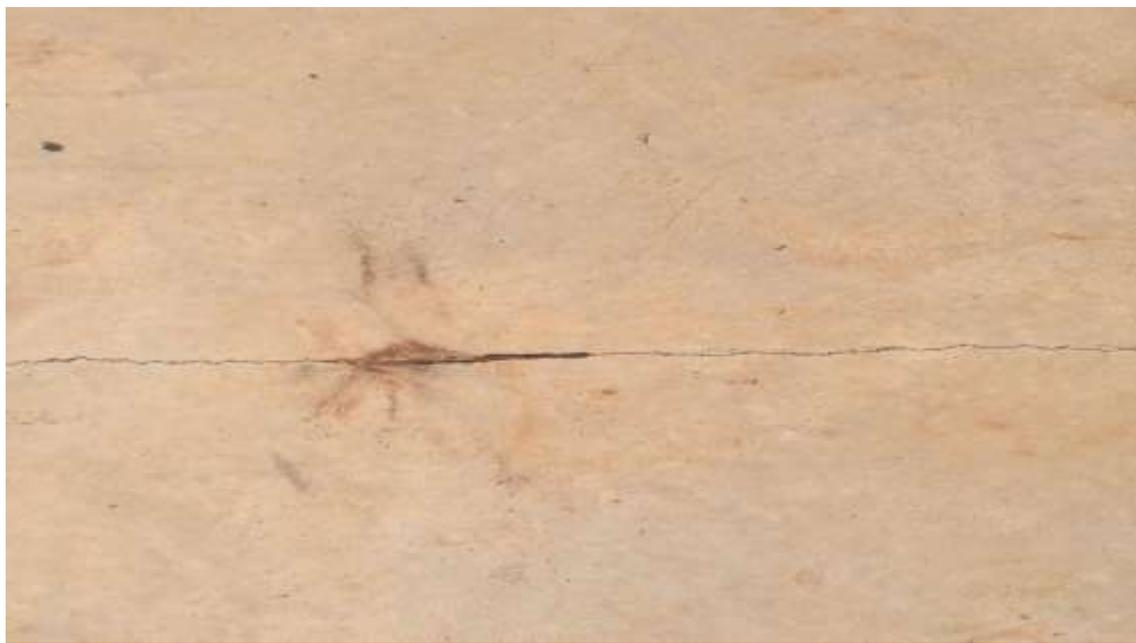
Foto 07 – Trinca no piso das quadras, armadura exposta.
