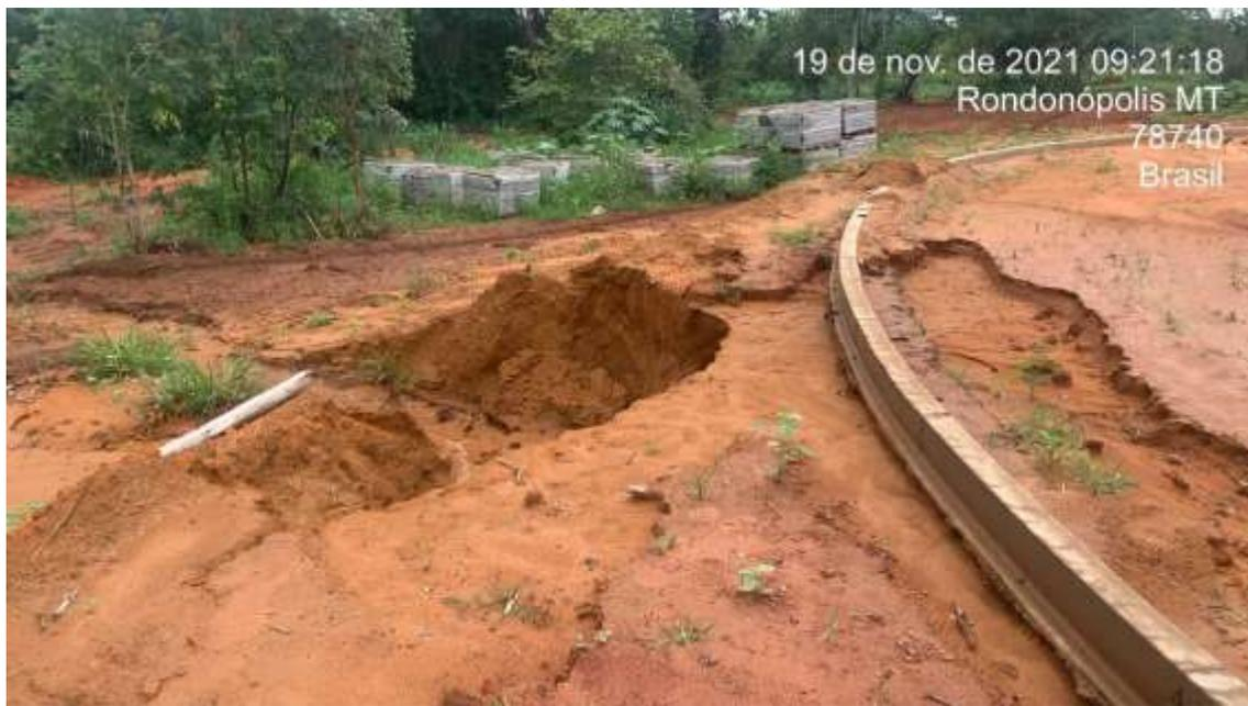
Foto 05 – Início de erosão, comprometendo a base e o meio fio.
