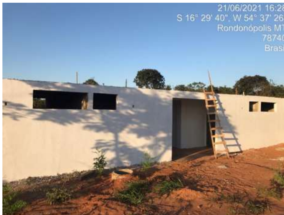
Foto 03 – Vestiário com frentes de trabalho liberadas e nenhum funcionário
