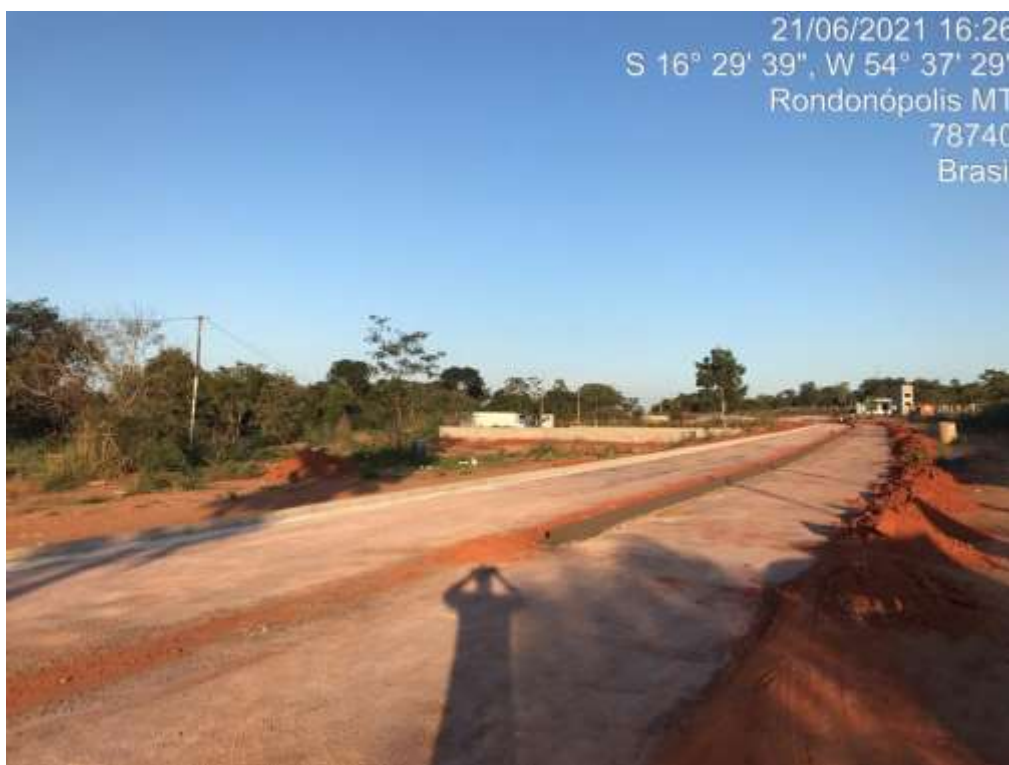
Foto 04 – Visão ampla da obra sem nenhum funcionário trabalhando
