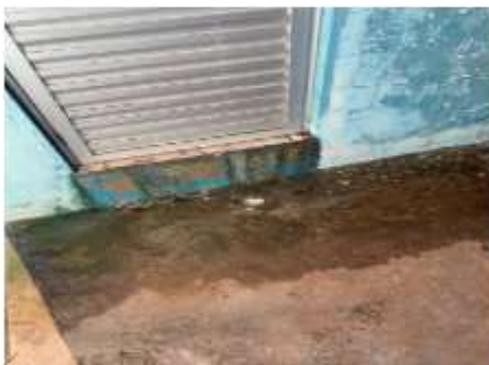
Foto 07 - INFILTRAÇÕES NA ESTRUTURA DA CAIXA D'ÁGUA.
