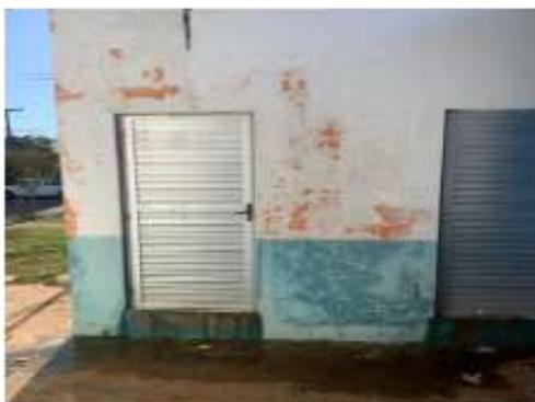
Foto 09 - INFILTRAÇÕES NA ESTRUTURA DA CAIXA D'ÁGUA.
