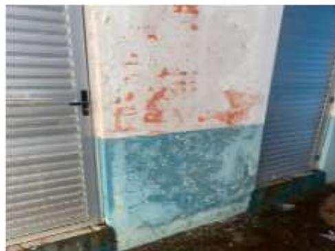
Foto 08 - INFILTRAÇÕES NA ESTRUTURA DA CAIXA D'ÁGUA.
