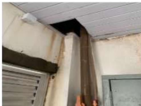
Foto 06 - VAZAMENTO DA CAIXA D'ÁGUA POR MÁ FIXAÇÃO DA BASE DA MESA.
