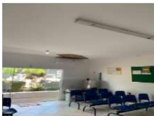
Foto 04 - DESCOLAMENTO DO REBOCO DA LAJE POR TRAÇO ERRADO.
