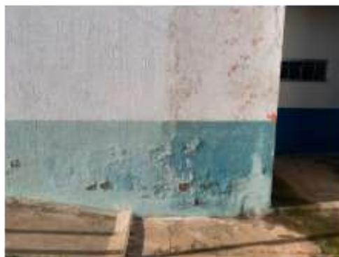
Foto 10 - INFILTRAÇÕES NA ESTRUTURA DA CAIXA D'ÁGUA.
