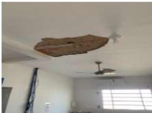
Foto 01 - DESCOLAMENTO DO REBOCO DA LAJE POR TRAÇO ERRADO.
