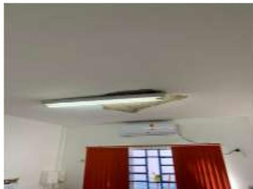
Foto 02 - DESCOLAMENTO DO REBOCO DA LAJE POR TRAÇO ERRADO.
