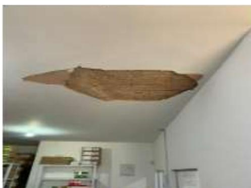
Foto 03 - DESCOLAMENTO DO REBOCO DA LAJE POR TRAÇO ERRADO.
