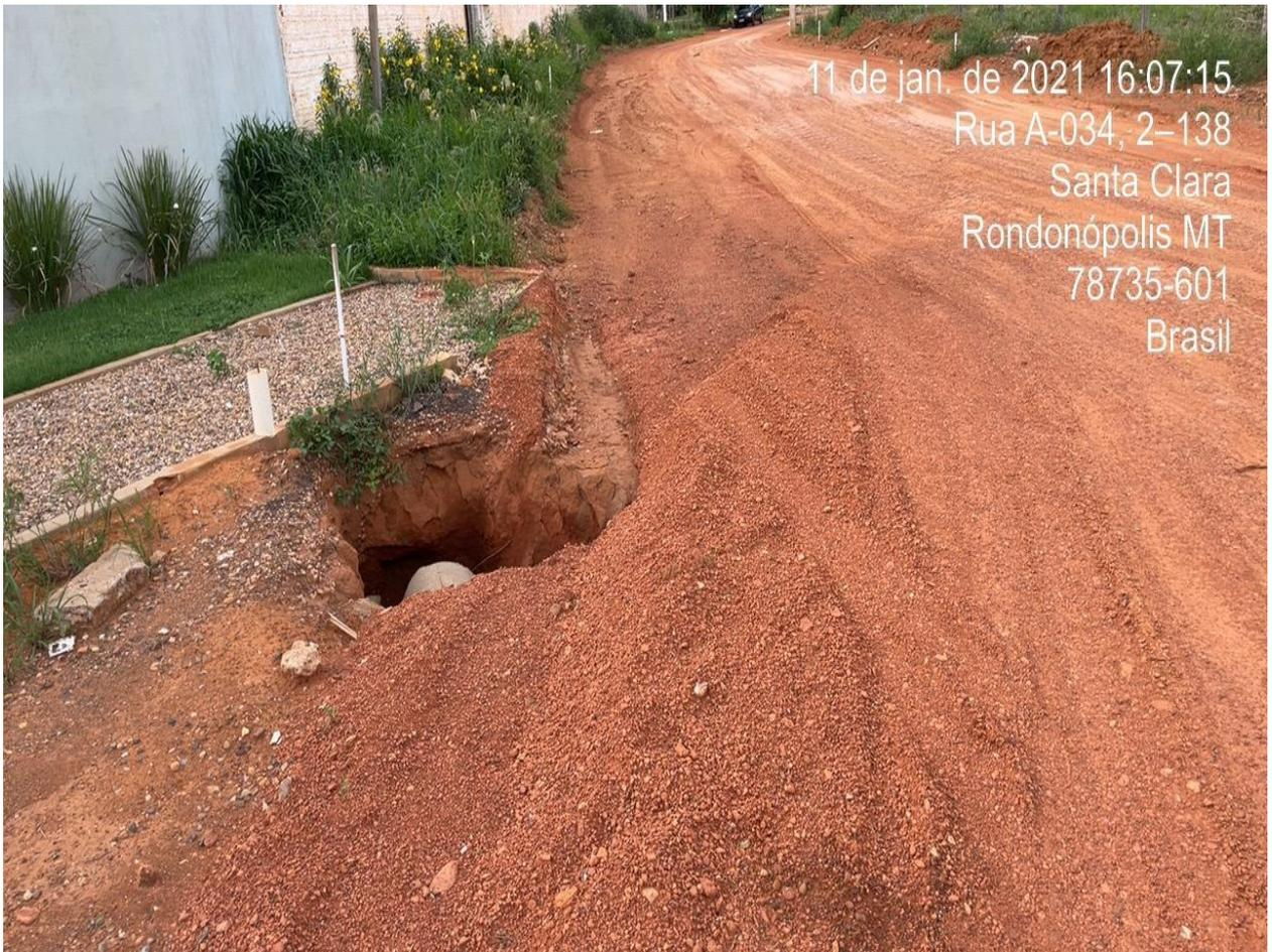
**Foto 06** – Observamos nesta imagem o assoreamento da saída de aterro, causando grande erosão ao greide do pavimento.
