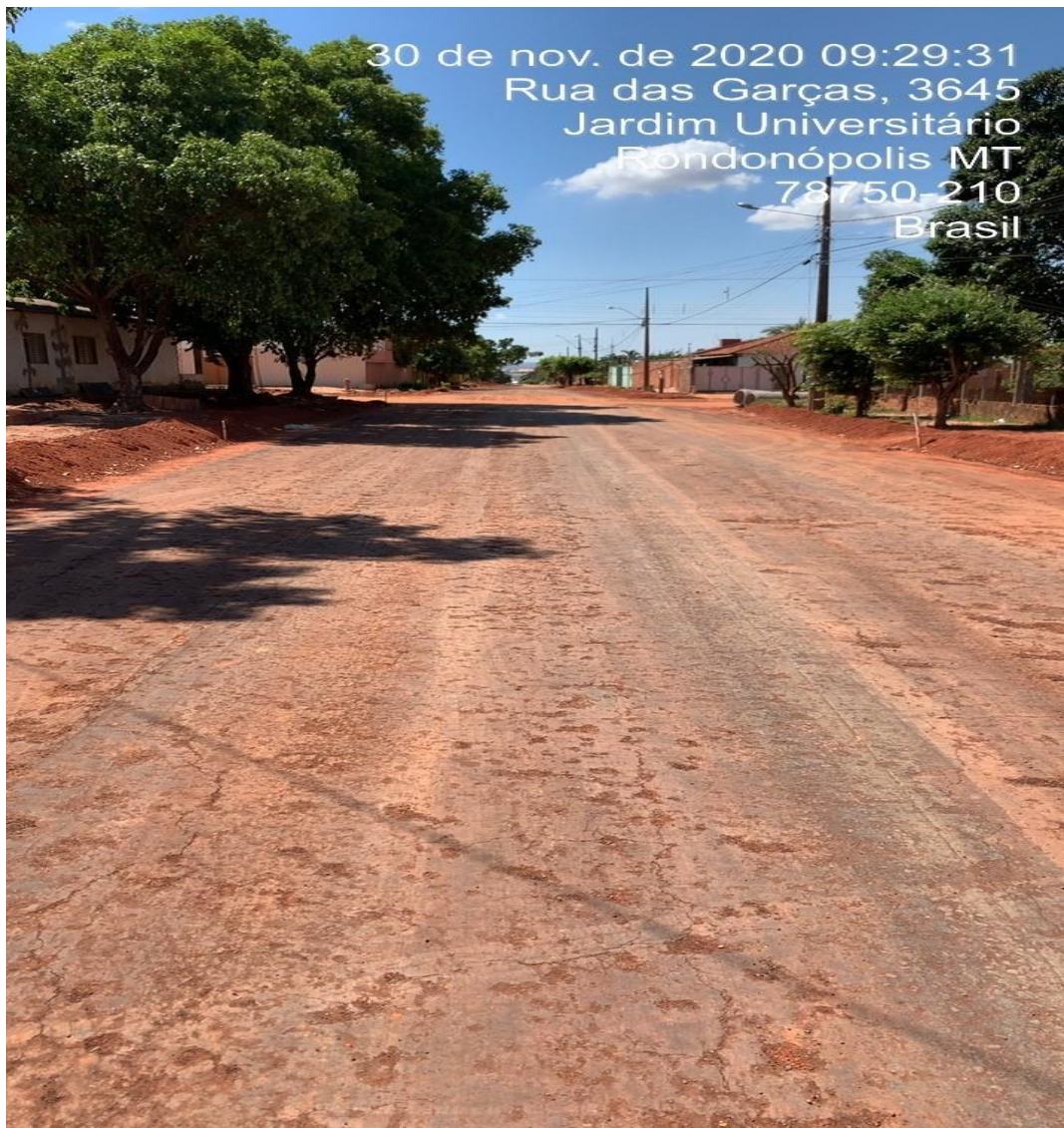
Foto 05 – Rua imprimada aguardando aplicação de revestimento asfáltico.
