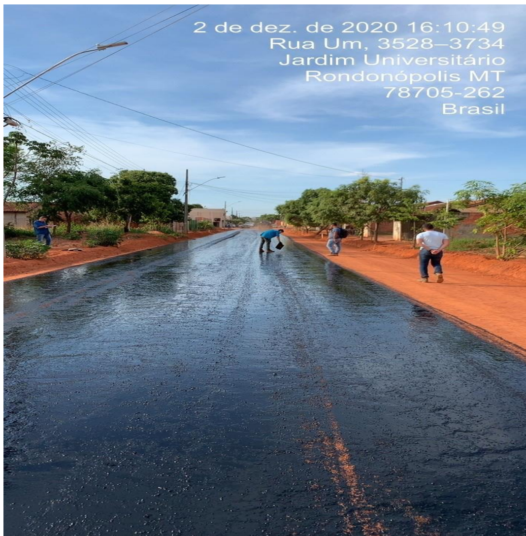
Foto 07 – Aplicação de imprimação com impermeabilizante.
