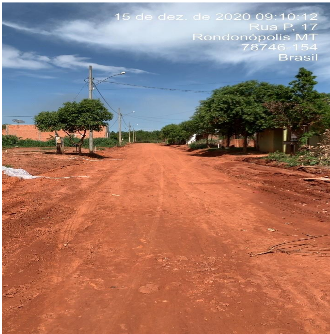
Foto 01 – Rua liberada para serviço de terraplenagem sem nenhum registro de atividade.
