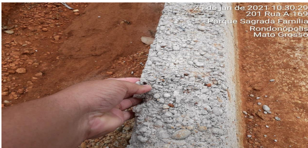
Foto 08 – Apresenta a coloração branca, 14 dias após a moldagem, o elemento apresenta esfarelamento.
