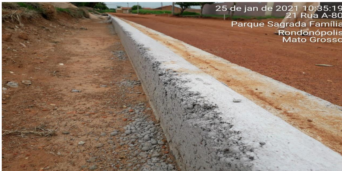
Foto 05 – Apresenta a coloração branca, sem junta de dilatação apropriada, 14 dias após a moldagem, o elemento apresenta esfarelamento.
