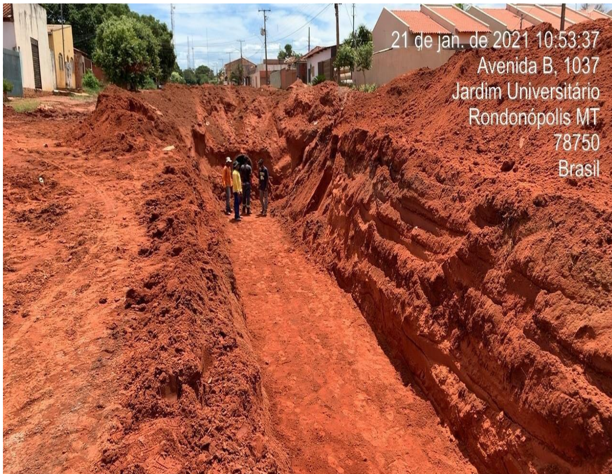
Foto 03 – Vala aberta para serviços de drenagem, resserviço de preenchimento de brita e assentamento de tubos de concreto.
