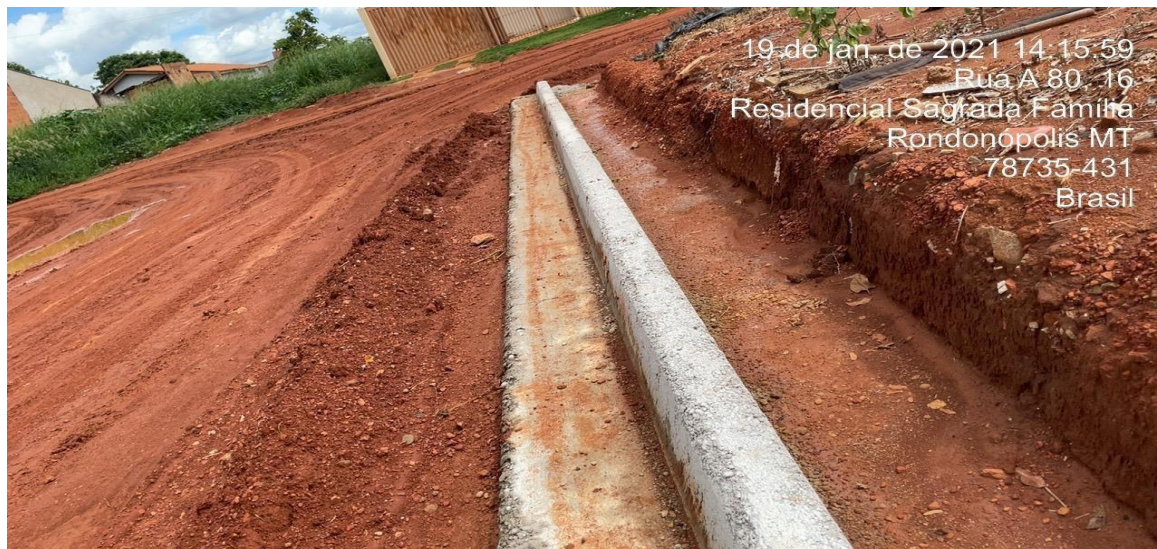
Foto 03 – Apresenta a coloração branca, sem junta de dilatação apropriada, 8 dias após a moldagem, o elemento apresenta esfarelamento.
