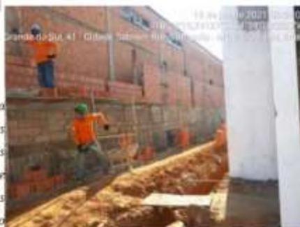
*Figura 04 – **Largura inferior do arrimo** – o local possui uma largura de 20 cm inclusive a execução do*
