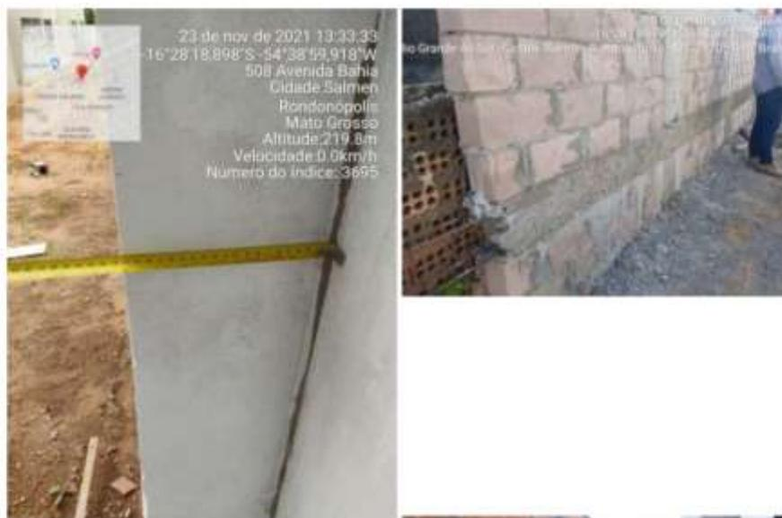
*Figura 05 – foto tirada na data de 15/06/2021 – nela imagem podemos ver **não execução** das canaletas citadas anteriormente, e conseqüentemente, a falta das armaduras longitudinais. O concreto apresenta aparente segregação, além do espaçamento dos estribos das armaduras com espaçamento aparentemente superior ao calculado.*
