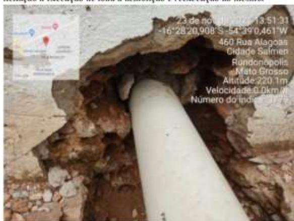
*Figura 18 – foto tirada na data de 23/11/2021, nela é possível ver vestígios do chapisco do embasamento antigo observando que, foi previsto em licitação a execução de toda a demolição e reexecução do mesmo. Assim, a aferição dos serviços referentes ao mesmo se tornam totalmente irregulares.*
