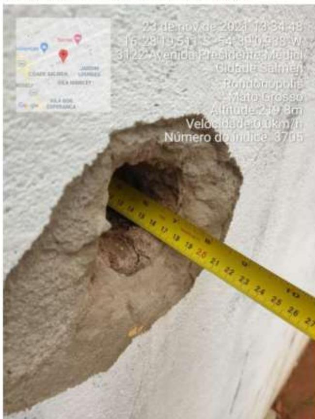
*Figura 01 – Largura executada de todo o perímetro inferior do muro de arrimo – podemos ver na imagem que o mesmo possui a largura total de 19 cm inclusive execução do emboço, acarretando na constatação de que os pilares dimensionados com uma seção de 20x20 cm (400cm<sup>2</sup>) foram executados com no máximo 14 cm, fragilizando toda a estrutura.*
