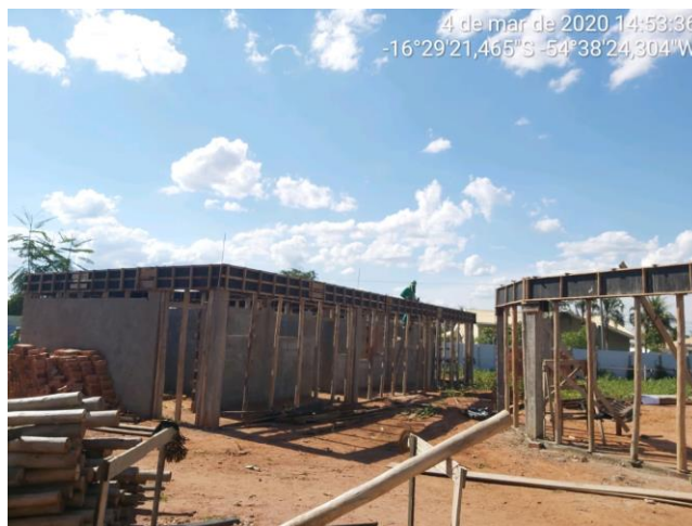
FOTO 03- BLOCO AINDA SEM LAJE.
