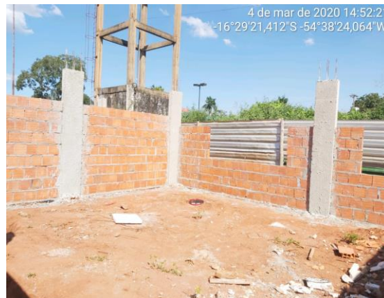
FOTO 02- BLOCO AINDA SEM LAJE.
