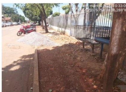
FOTO 02- CALÇADA APENAS DEMOLIDA, SEM LASTRO DE BRITA, E SEM GABARITO.
