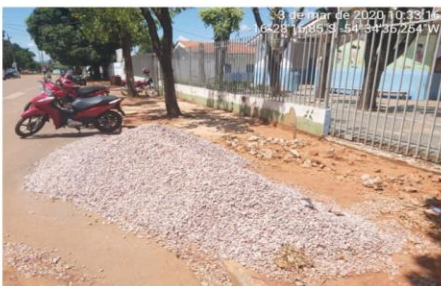
FOTO 03- BRITAS COLOCADA EM LOCAL INDEVIDO.
