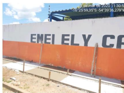
FOTO 02– CALÇADA APENAS COM A CONCRETAGEM, SEM PISOS TÁTEIS, PLANTIO DE GRAMA E O PLANTIO DE ÁRVORES.
