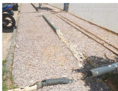
FOTO 02– CALÇADA APENAS COM LASTRO DE BRITA, AINDA NÃO CONCRETADA.
