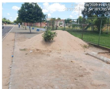
FOTO 02- AREIA COLOCADA NO LOCAL INDEVIDAMENTE.
