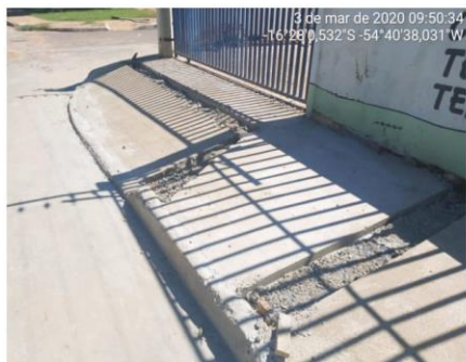
FOTO 03 –CALÇADAS APENAS CONCRETADA
