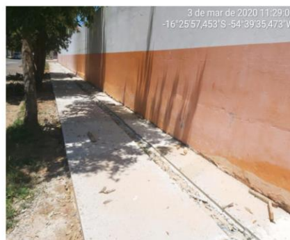
FOTO 04– LATERAL APENAS COM A CONCRETAGEM E SEM OS PISOS TÁTEIS.
