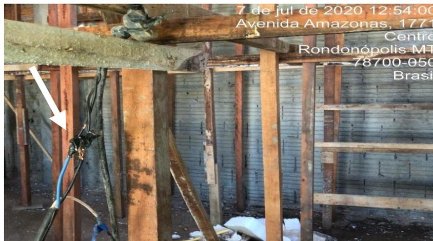
Foto 01: Imagem da extensão com a fiação sem isolamento oferecendo riscos os colaboradores.
