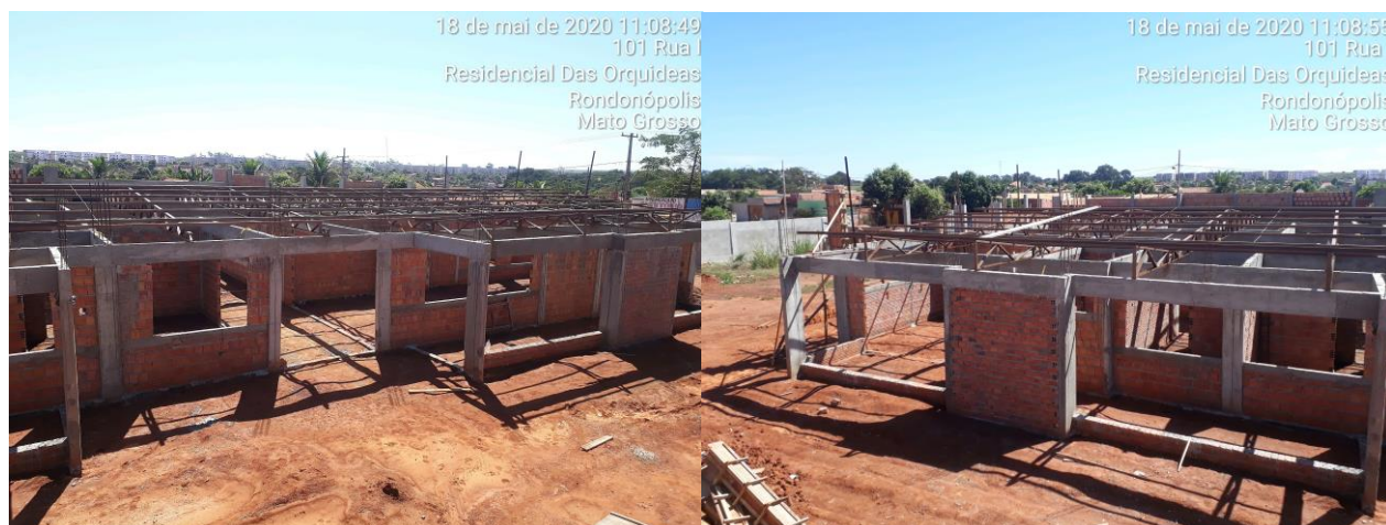
Figura 1- ESTRUTURA METALICA BLOCO A
