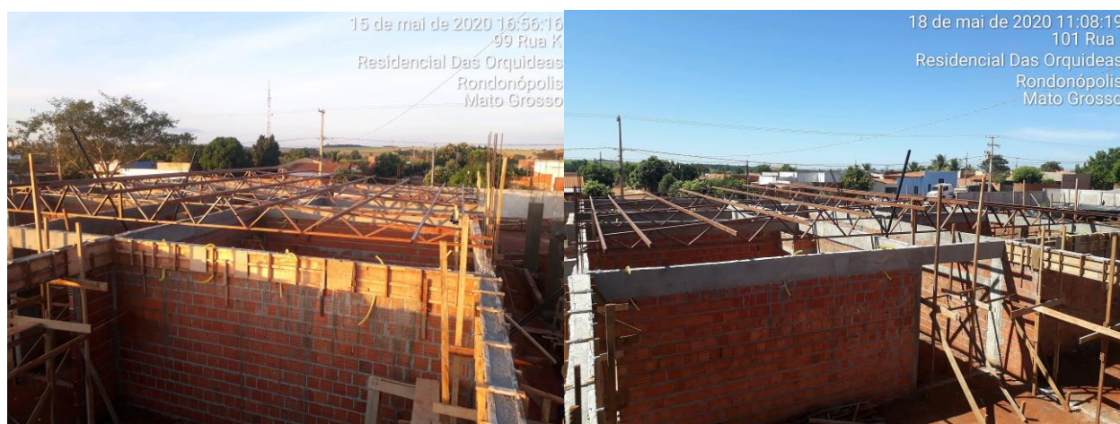
Figura 2 - ESTRUTURA METALICA BLOCO B
