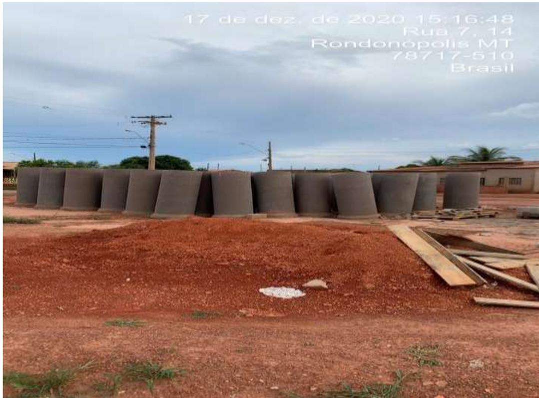
Foto 02 – Manilhas para execução de drenagem encostadas.
