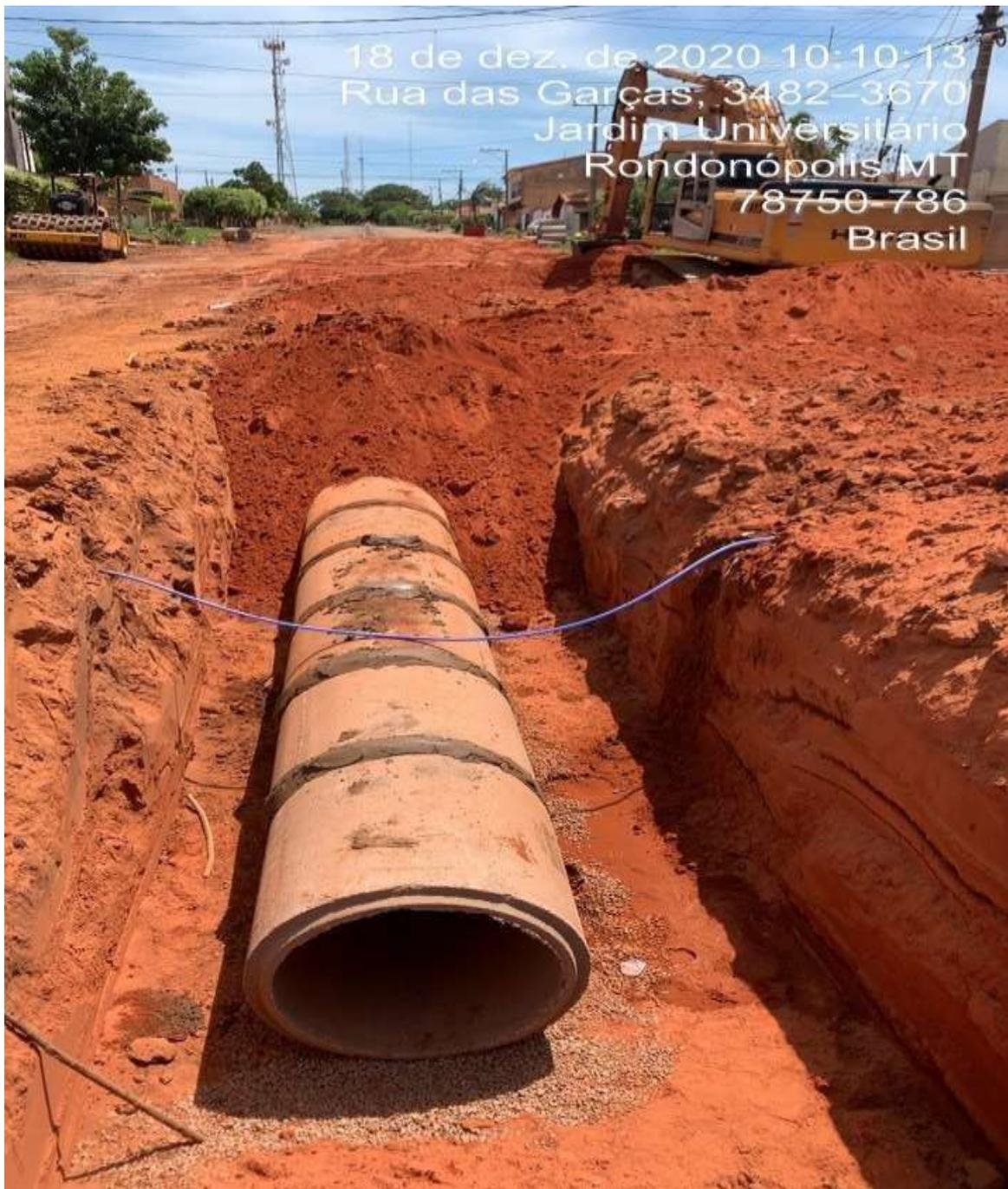
O registro fotográfico mostra os tubos de concreto assentados em base sem receber compactação e com lastro de brita colocado sem preencher toda área do fundo da vala, com espessura menor que a de projeto, sendo reaterado em volume único sem compactação, evidenciando a execução do serviço de drenagem em desacordo as normas técnicas vigente, consubstanciando o descumprimento a boa técnica construtiva necessária aos serviços e obras de engenharia.
