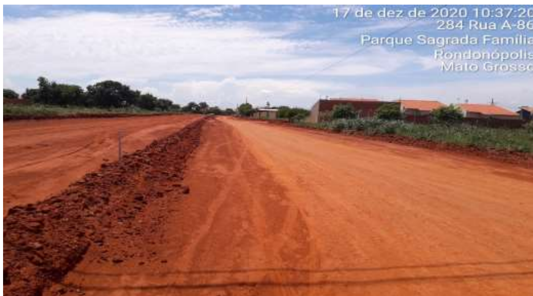
Foto 01 – Ruas e avenidas com frentes de trabalho liberadas.
