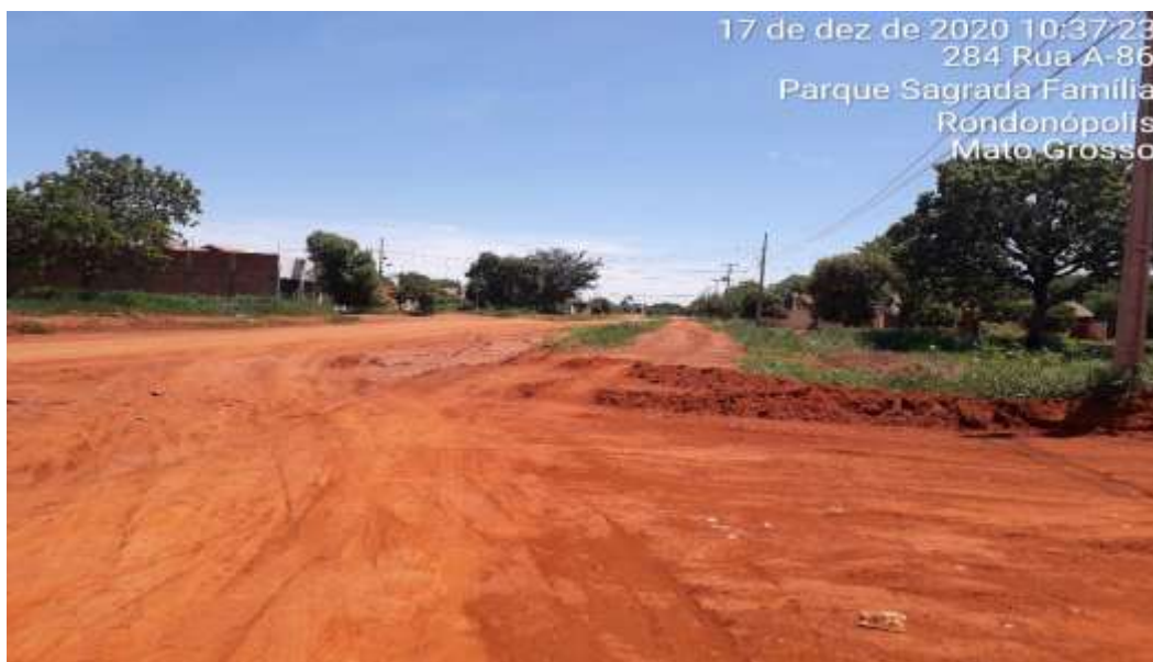
Foto 02 – Ruas e avenidas com frentes de trabalho liberadas.
