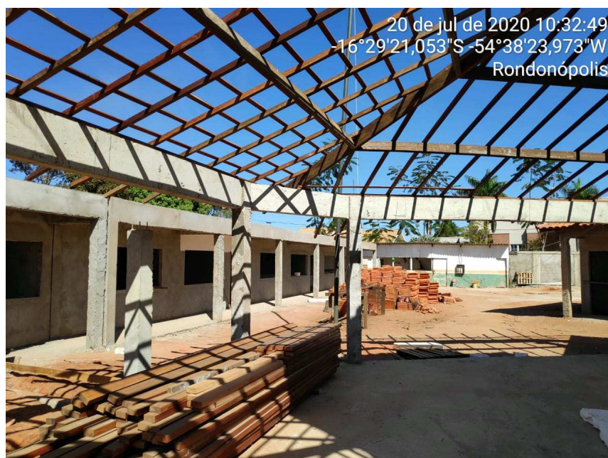
Figura 04: Situação da obra de construção.
