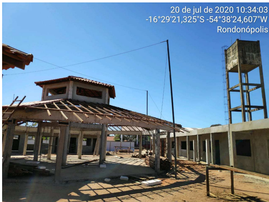
Figura 05: Situação da obra de construção.
