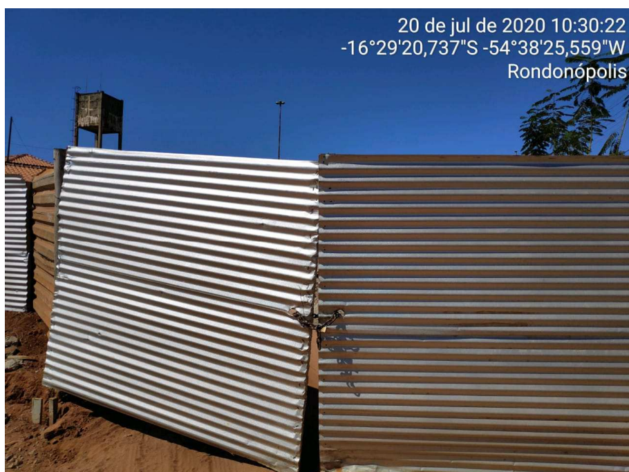
Figura 08: Situação da obra de construção.
