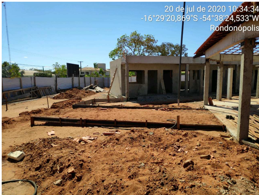
Figura 03: Situação da obra de construção.
