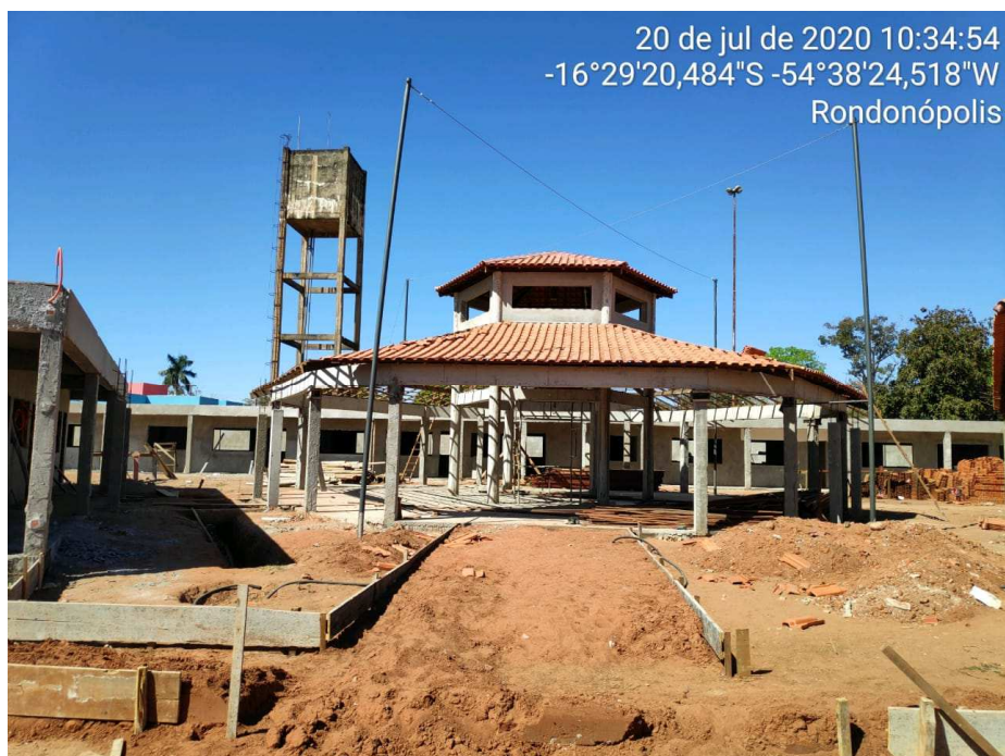
Figura 02: Situação da obra de construção.
