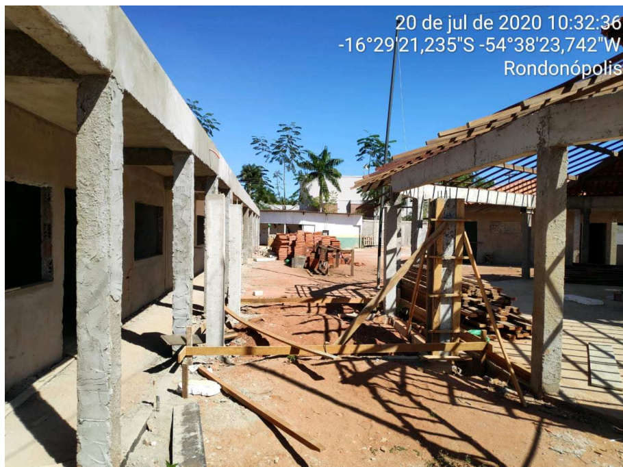
Figura 07: Situação da obra de construção.
