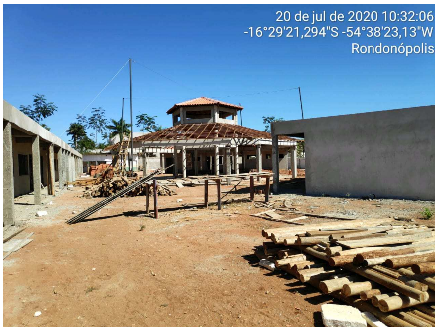
Figura 06: Situação da obra de construção.
