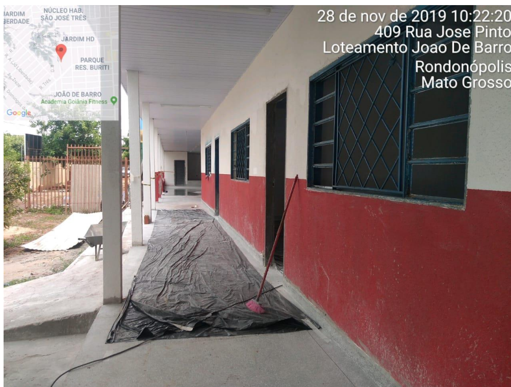
Foto 02 – Bloco 01 com serviços atrasados, onde o mesmo já deveria ter sido entregue.
