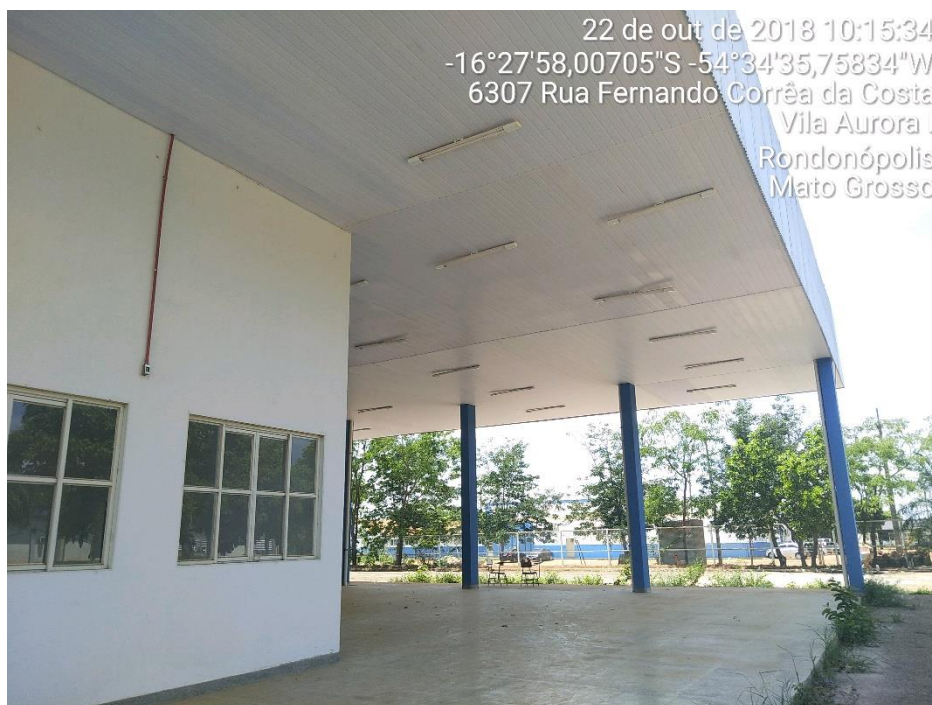
Foto 01 – Situação da obra “PRONAF” (Contrato 122/2016)
