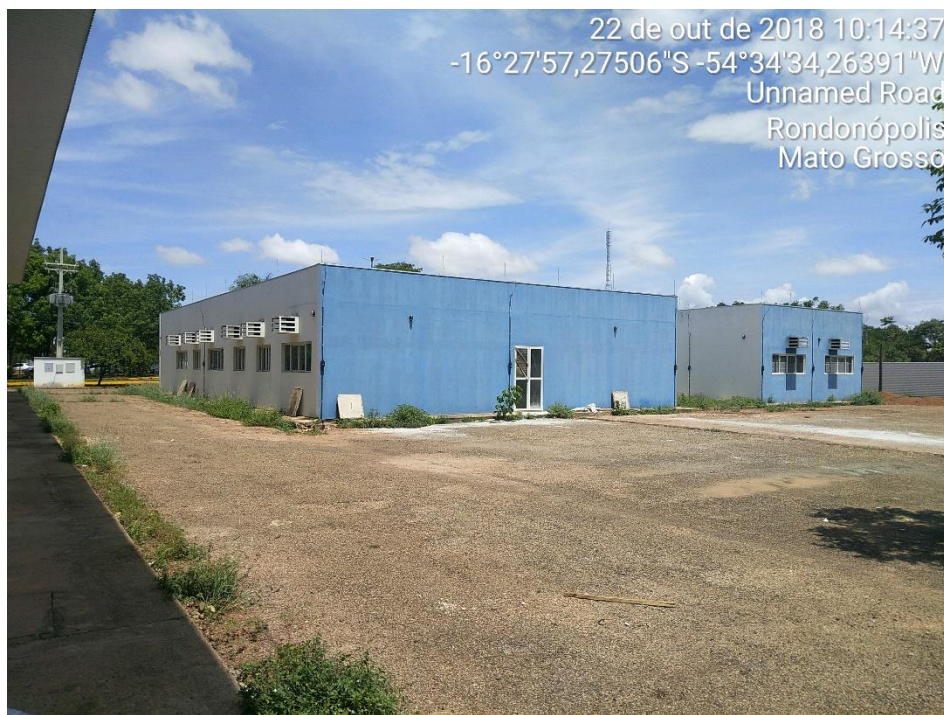
Foto 02 – Situação da obra “PRONAF” (Contrato 122/2016)
