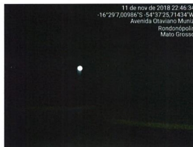
Foto 02 - LUMINÁRIAS APAGADAS DO POSTE ARVORE
