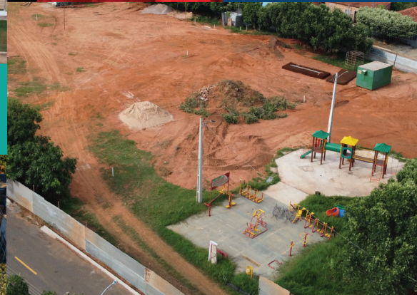
EM ANDAMENTO CONSTRUÇÃO DA ÁREA DE LAZER PADRE JOÃO BOSCO BURNIER
