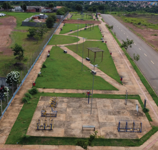
CONSTRUÇÃO DE PRAÇA EM FRENTE AO IFMT
