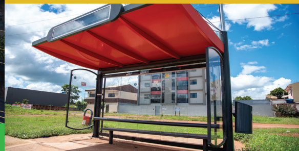
IMPLANTAÇÃO DE NOVAS COBERTURAS DE PONTO DE ÔNIBUS
