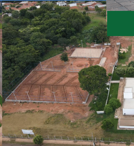
EM ANDAMENTO CONSTRUÇÃO DA ÁREA DE LAZER NO IFMT
