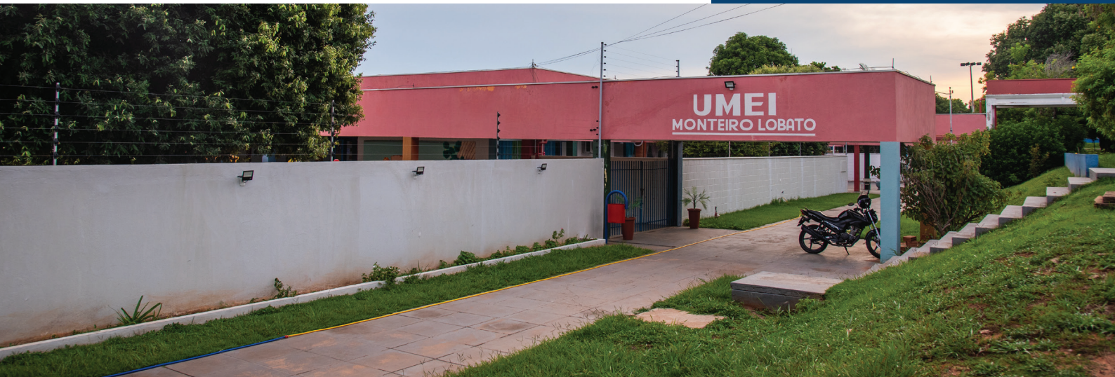
REFORMA DA CRECHE MONTEIRO LOBATO
