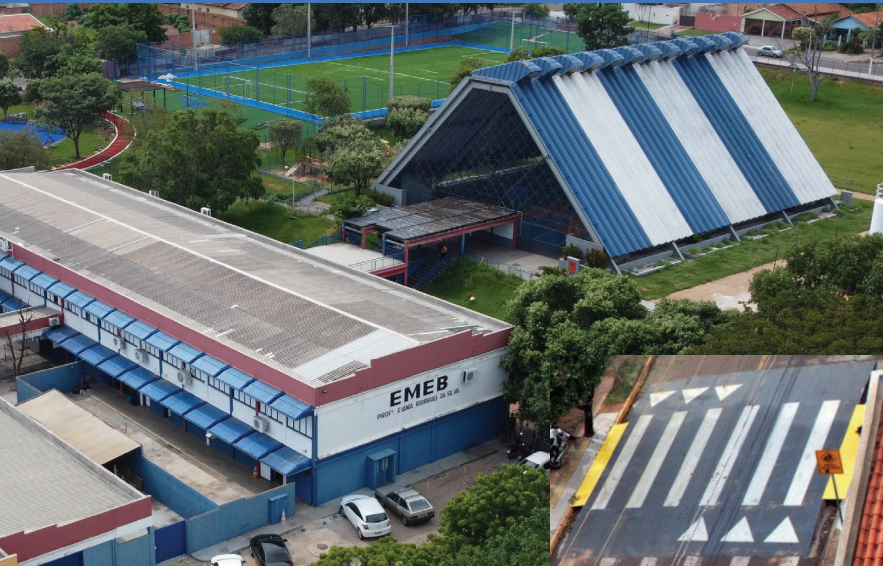
REFORMA DA ESCOLA CAIC E CONSTRUÇÃO DA FAIXA ELEVADA
