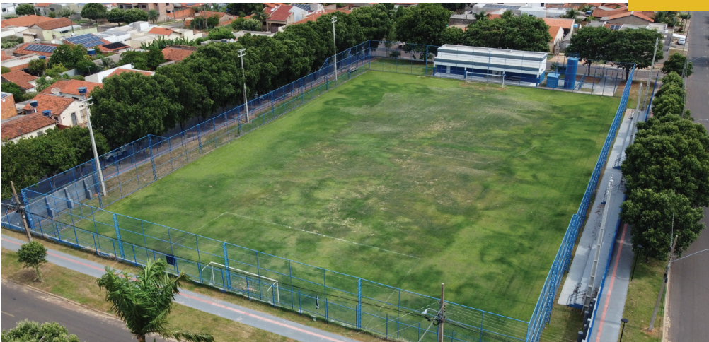
CONSTRUÇÃO DO MINIESTÁDIO JARDIM TROPICAL
