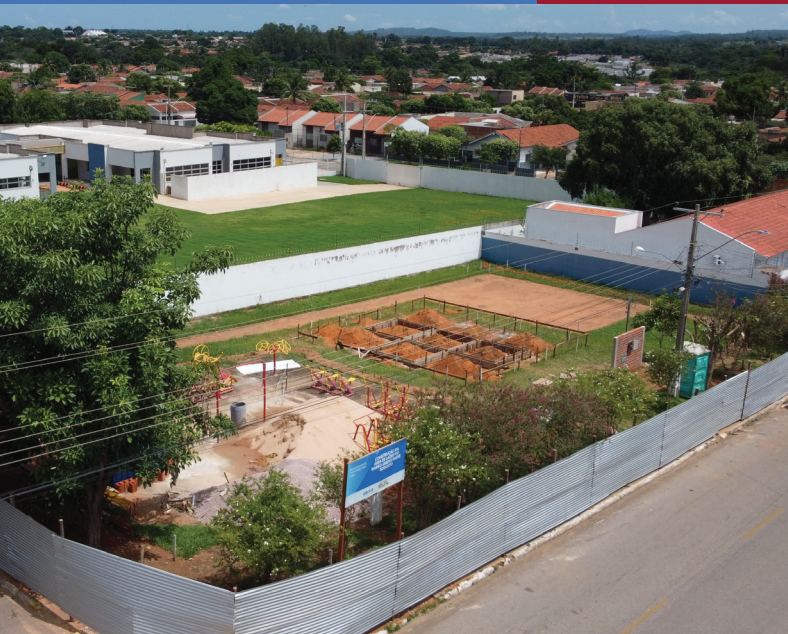
EM CONSTRUÇÃO ÁREA DE LAZER NO PADRE RODOLFO
