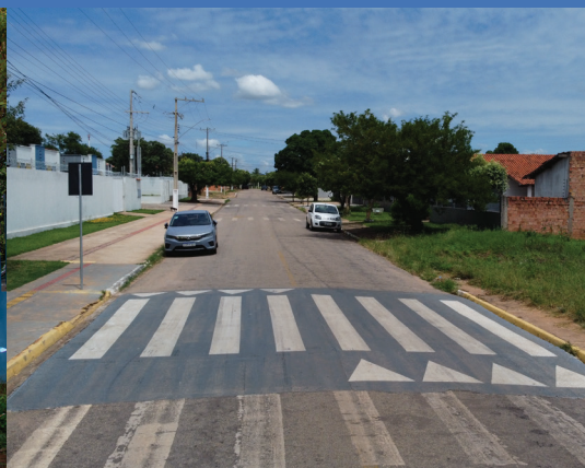
IMPLANTAÇÃO DE FAIXAS ELEVADAS EM DIVERSOS LOCAIS
