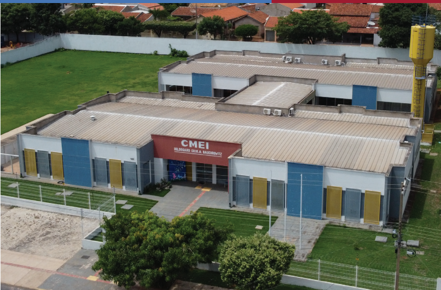
CONSTRUÇÃO DA CRECHE HILDEGARD ÉRIKA BAWCHROWITZ NO PADRE RODOLFO
