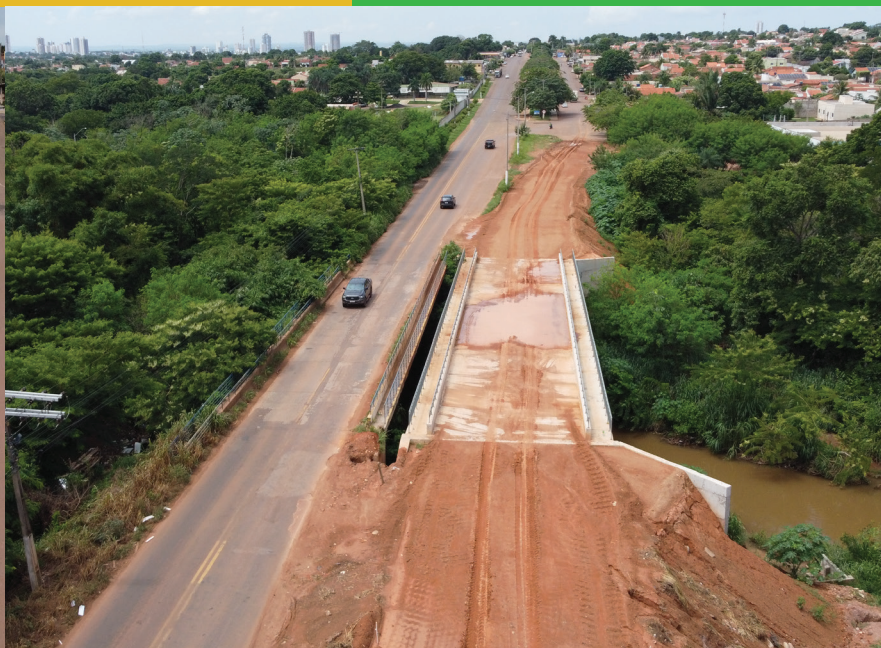
DUPLICAÇÃO DA AV. BANDEIRANTES E CONSTRUÇÃO DE PONTE
