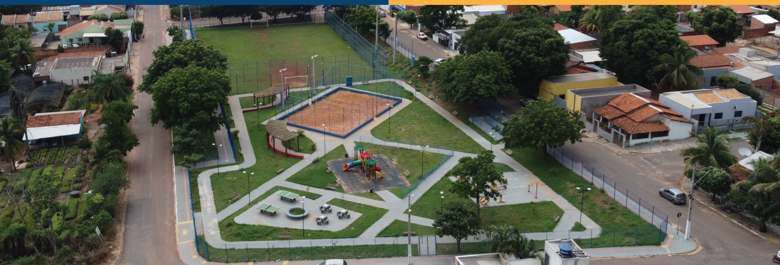
CONSTRUÇÃO DA PRAÇA JOÃO MACHADO - JD NILMARA
