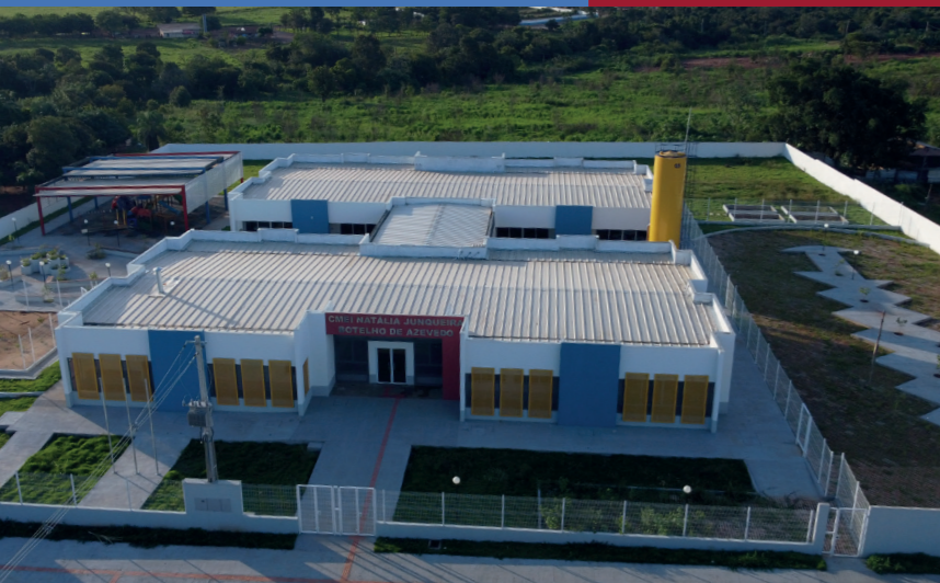
CONSTRUÇÃO DA CRECHE NO PEDRA 90 NATÁLIA JUNQUEIRA BOTELHO DE AZEVEDO
