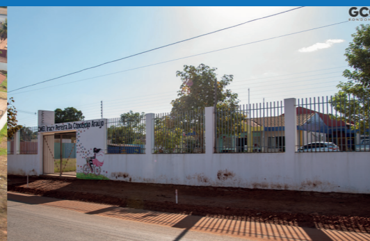
REFORMA DA CRECHE IRACY DA CONCEIÇÃO ARAÚJO - JD. DAS PAINEIRAS
