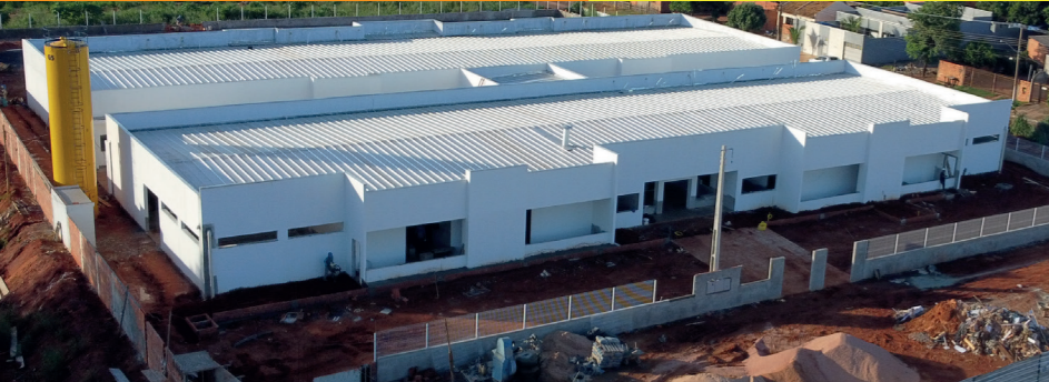
EM ANDAMENTO - CONSTRUÇÃO DE ESCOLA DE TEMPO INTEGRAL NO PEDRA 90
