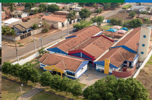
REFORMA DA CRECHE JOANA MARIA DOS ANJOS - TANCREDO NEVES
