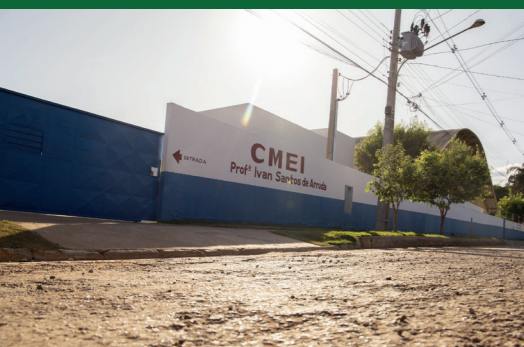
REFORMA E AMPLIAÇÃO DA CRECHE PROF. IVAN SANTOS NO PQ. UNIVERSITÁRIO
