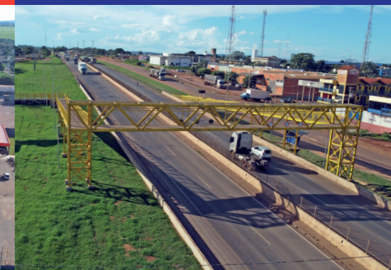
CONSTRUÇÃO DE PASSARELA NA BR-364 (PARCERIA PREFEITURA E GOVERNO FEDERAL)
