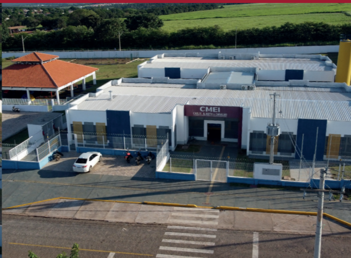
CONSTRUÇÃO DA CRECHE NO ROSA BORORO CARLOS ALBERTO DE CARVALHO
