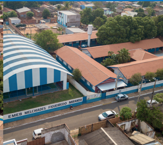
REFORMA DA ESCOLA MELCHIADES E CONSTRUÇÃO DA QUADRA - PEDRA 90
