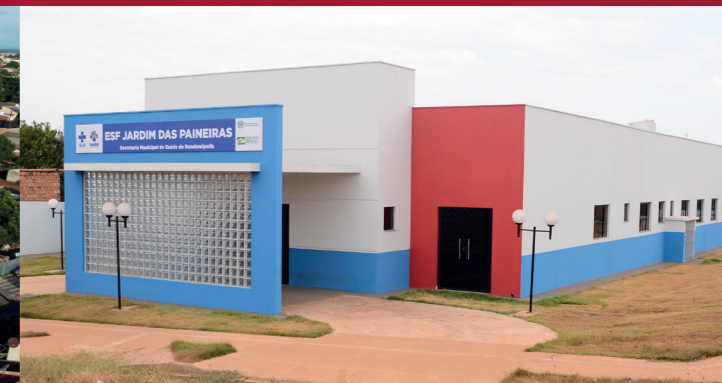
CONSTRUÇÃO DA UNIDADE BÁSICA DE SAÚDE - JD. PAINEIRAS
