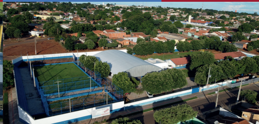
REFORMA DA ESCOLA TANCREDO NEVES
