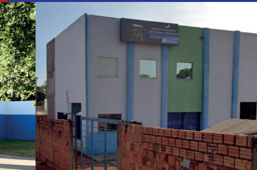
REGULARIZAÇÃO DA ENTIDADE FILANTRÓPICA INSTITUTO DOUTRINÁRIO DA CRIANÇA E DO ADOLESCENTE PEDRA 90
